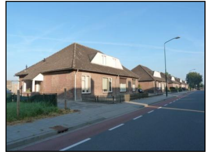
Figuur 4. Te slopen woningen aan de Sweensstraat.
