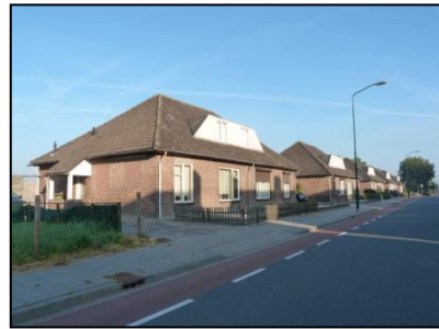
Figuur 5. Te slopen woningen aan de Sweensstraat.
