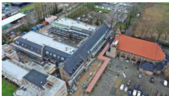
Figuur 2.6: Foto bouwdeel 1 in aanbouw (begin 2020)
