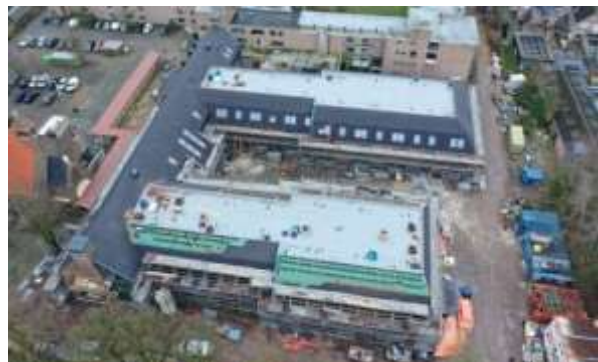
Figuur 2.7: Foto bouwdeel 1 in aanbouw (begin 2020)
