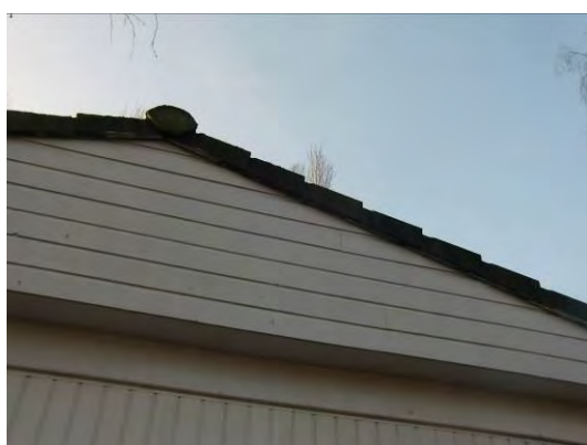
Figuur 9. Dakrand chalet.
