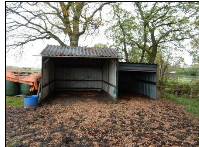
Figuur 8. Stallen noordwestelijk deel onderzoekslocatie.
