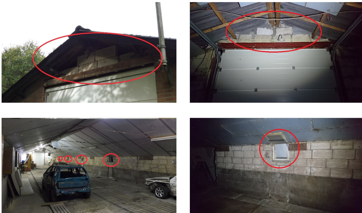
Afbeelding 4: Afgedichte gevelopeningen. Links de open situatie op 21-10-2016, rechts de afgedichte situatie op 17-03-2017. Foto: T.D. Breur - Ecoresult B.V.
