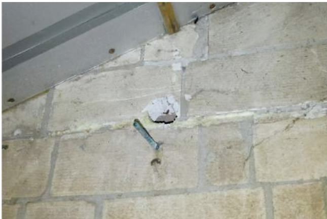
Potentie voor vleermuisverblijfplaatsen in de muur
