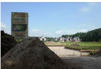
In aanbouw zijnde woning Liesdaalweg 5
