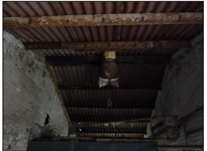
Detail binnenzijde te slopen bebouwing
