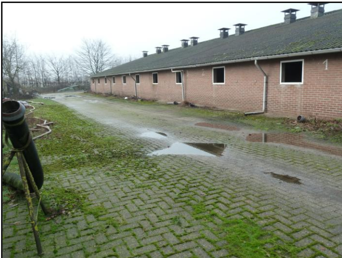
Zicht op het erf en te slopen bebouwing
