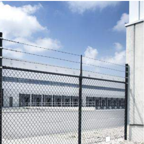
referentie: hekwerk met fauna passage (30cm vrije ruimte) materiaal: staal kleur: grijs / thermisch verzinkt
