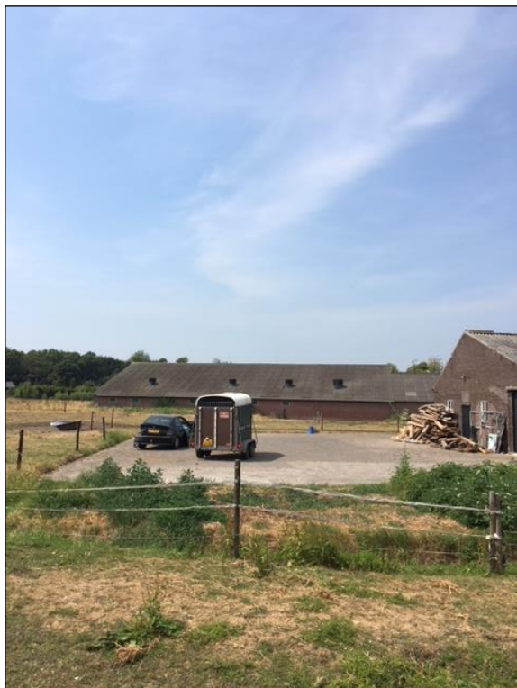
Achterzijde te slopen bedrijfsbebouwing
