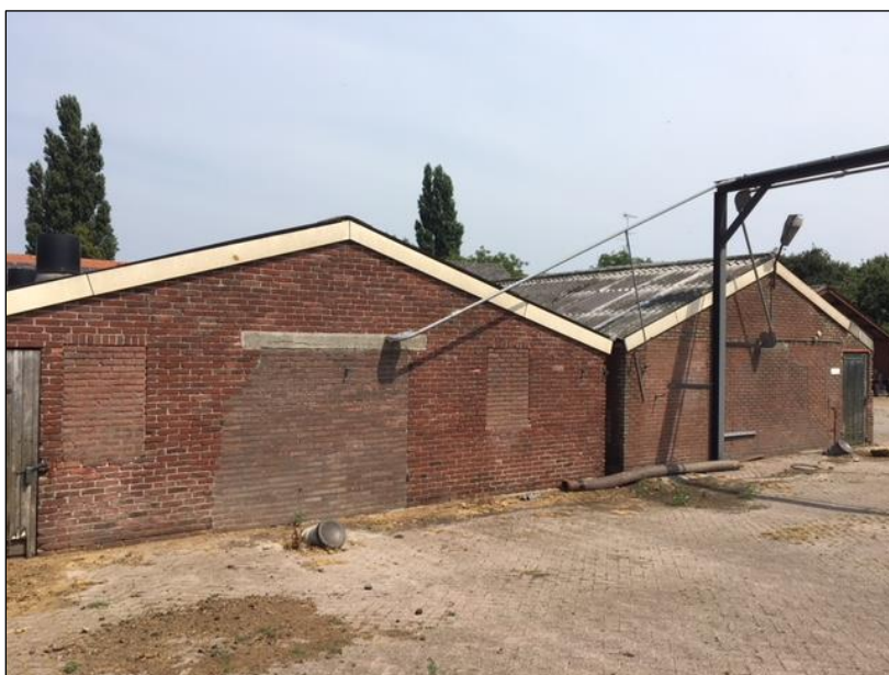
Achterzijde te slopen varkensstallen voorerf
