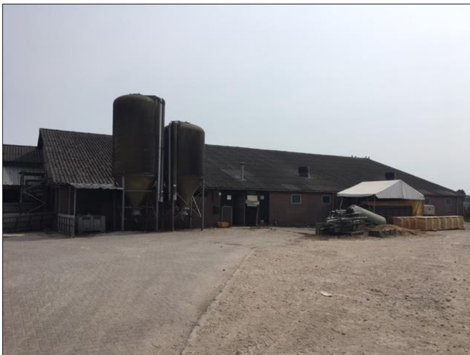
Te slopen bedrijfsbebouwing
