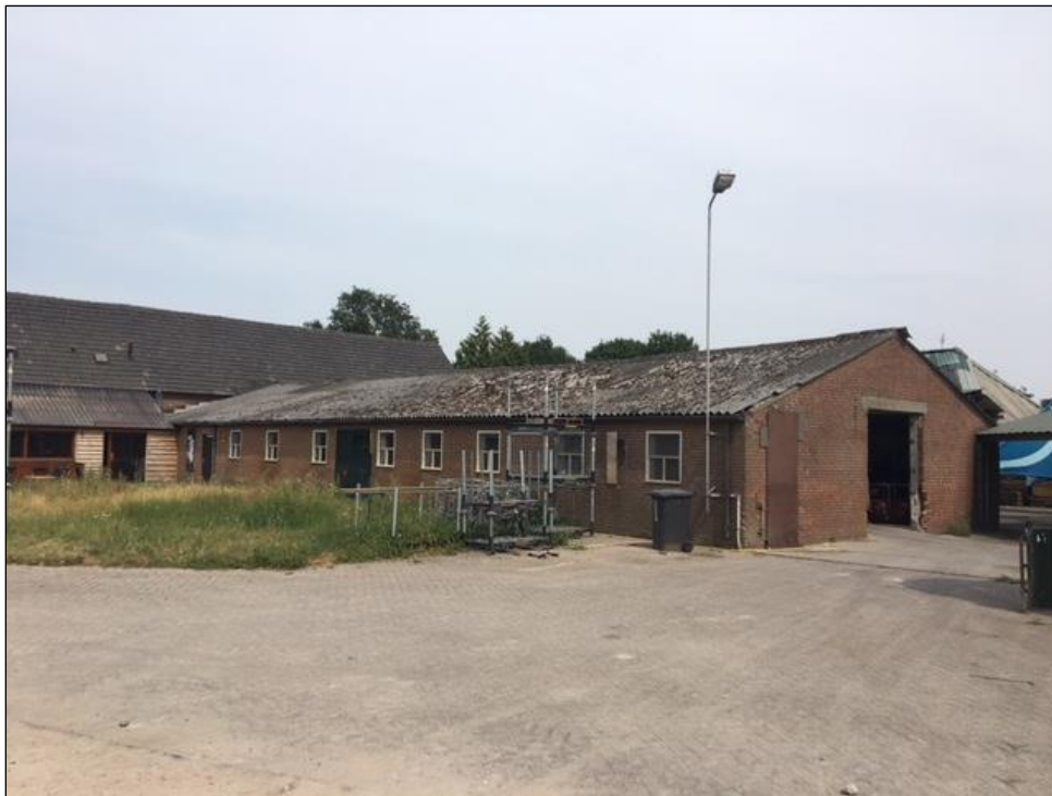
Te slopen bedrijfsbebouwing
