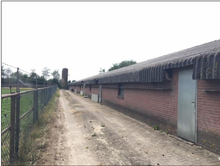
Te slopen bedrijfsbebouwing
