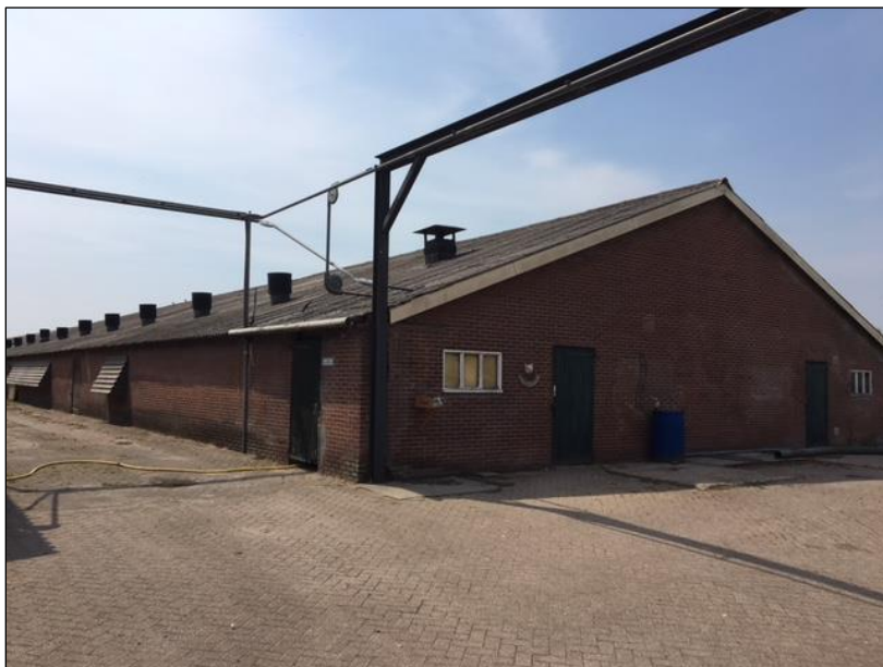
Voorzijde te slopen varkensstallen achtererf
