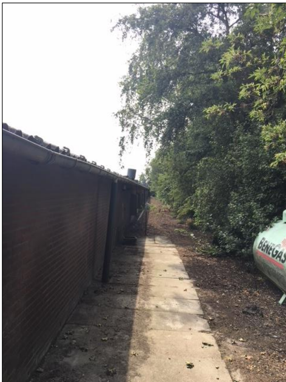
Te slopen bedrijfsbebouwing
