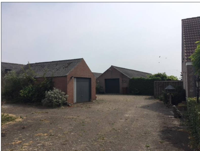
Te slopen bedrijfsbebouwing
