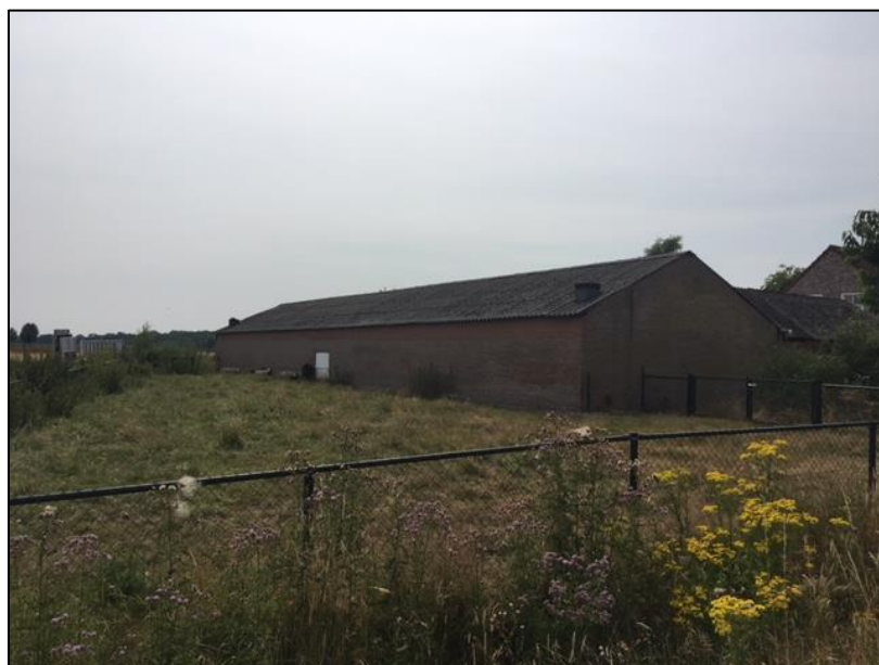
Te slopen bedrijfsbebouwing, tevens locatie ruimte-voor-ruimte woning
