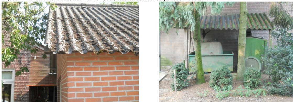
Figuur 2.2: Foto links: asbestdak zonder goot, foto rechts: bovengrondse dieseltank
