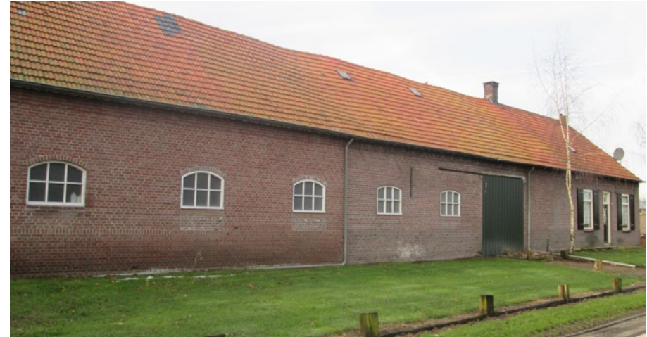
Groenstraat 16: De langgevelboerderij en later gerealiseerde aanbouw kan worden herbestemd en opgeplitst.
