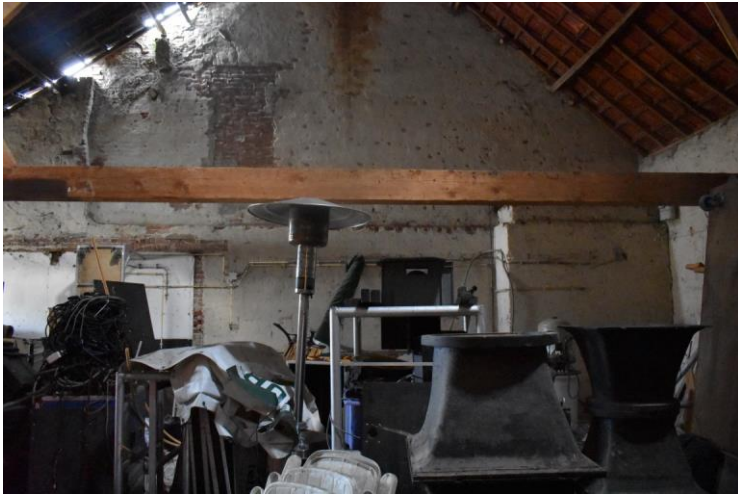
Bedrijfsgedeelte richting de brandmuur.
