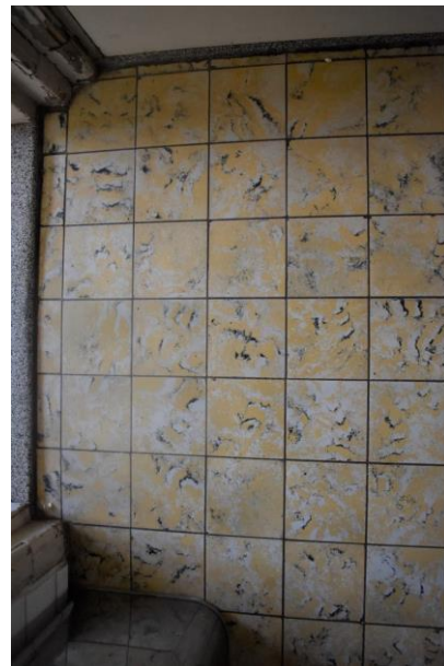
Tegelvloer in keuken.
