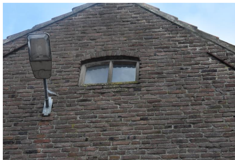
Betonvenster in top linkerzijgevel.
