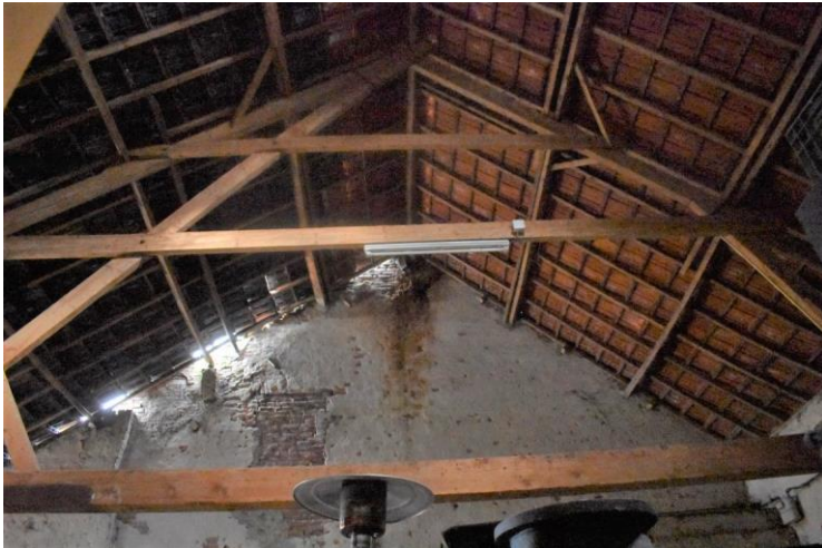
Spantconstructie in het bedrijfsgedeelte.
