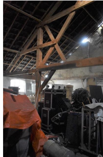
Spantconstructie in het bedrijfsgedeelte.
