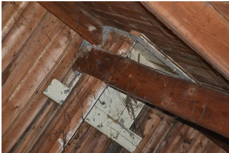
Detail voormalige opening t.b.v. rookkanaal.
