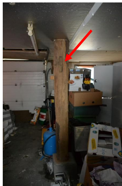
Achterste gebintstijl met afgezaagd korbeel.
