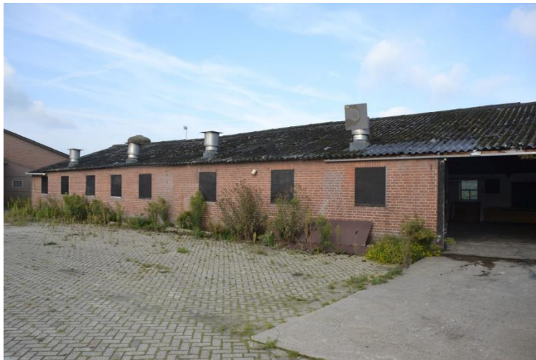
De later aangebouwde stal naar het zuidwesten gezien.
