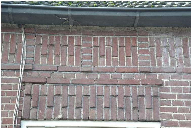
Siermetselwerk in de strek boven deuren en venster en het fries.
