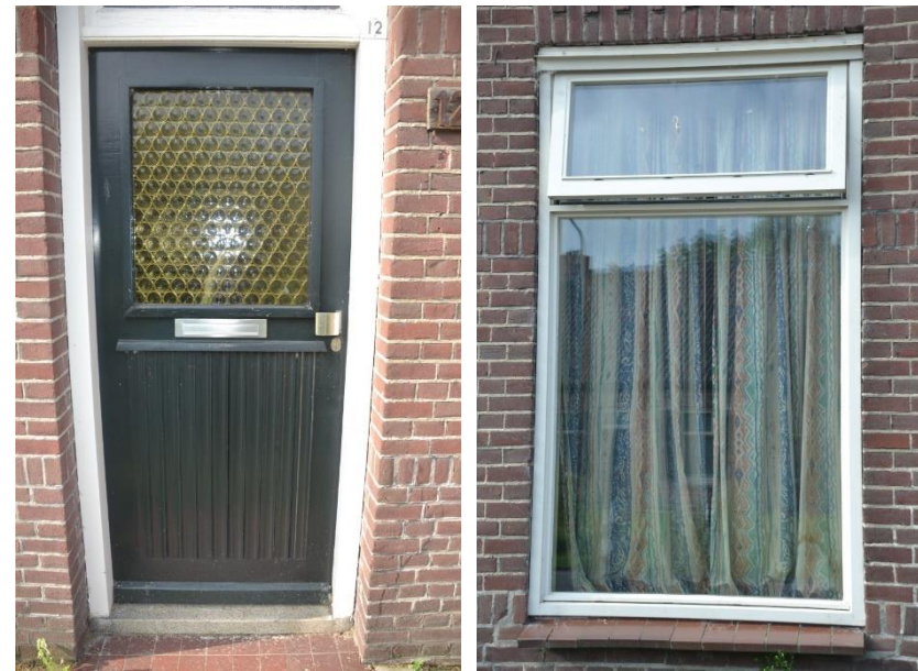
Links: voordeur in de voorgevel. Rechts: één van de twee vensters aan weerszijden van de voordeur.
