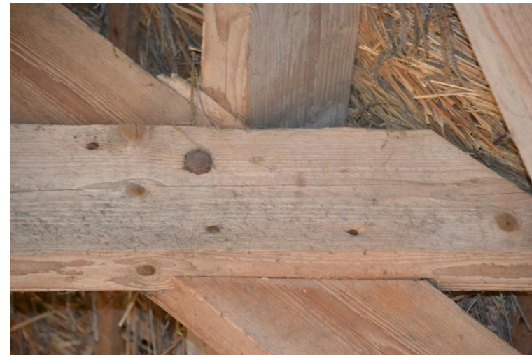
Detail bevestiging spantbenen met bouten.
