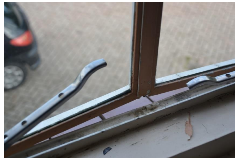
Detail stalen vensters in de rechterzijgevel.
