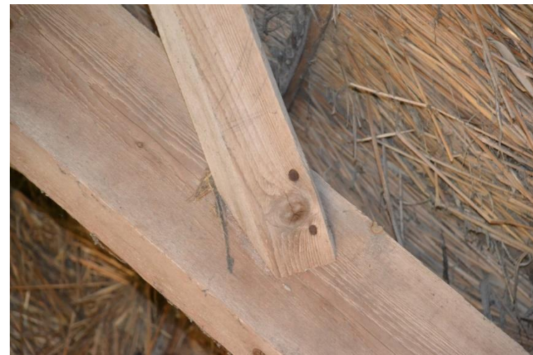
Detail bevestiging schoren met spijkers.
