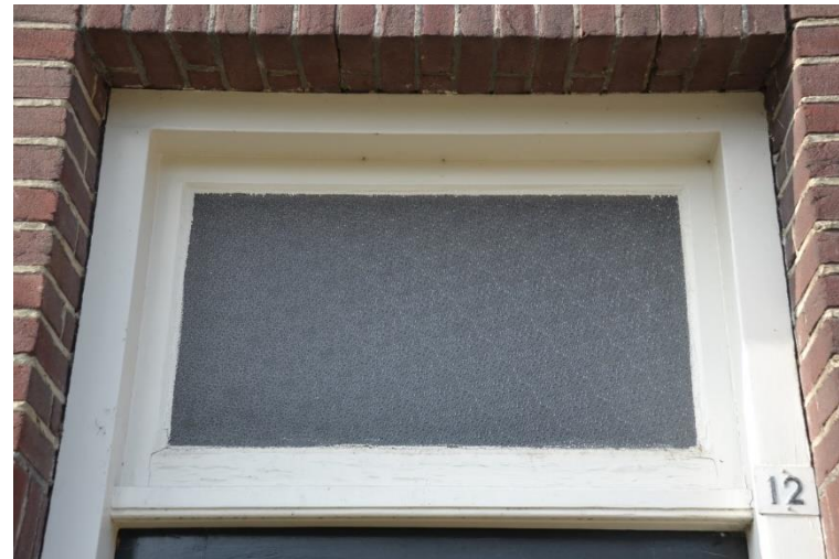
Het bovenlicht boven de voordeur met figuurglas.
