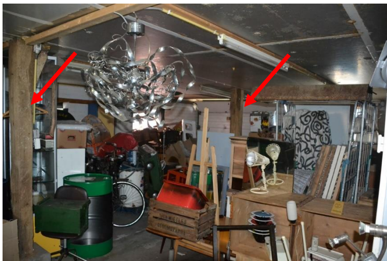
Interieur van het bedrijfsgedeelte met gebintstijlen.
