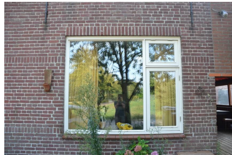
Eén van de twee vensters op de begane grond.
