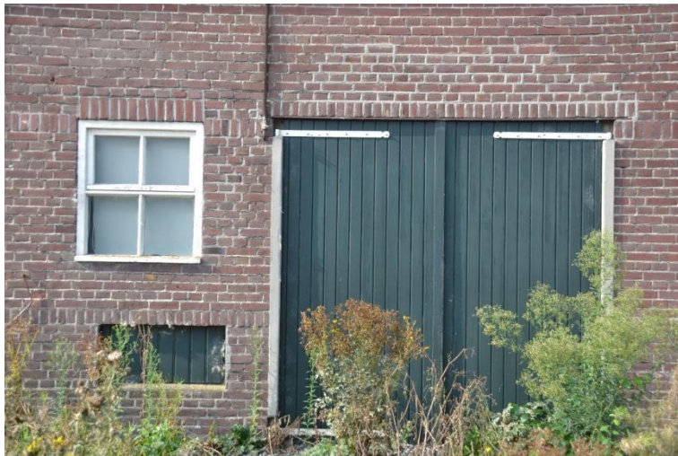
Dubbele staldeuren in de voorgevel met links een opening, waarvan de functie onduidelijk is.
