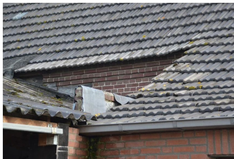
Gedeelte van de oorspronkelijke achtergevel.
