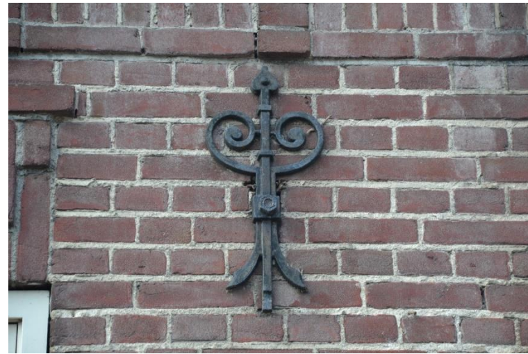
Eén van de sierankers in de voorgevel t.h.v. het woonhuisgedeelte.
