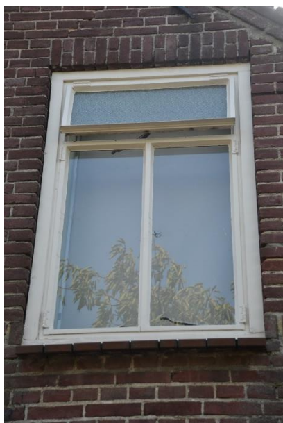
Stalen raam in rechterzijgevel.
