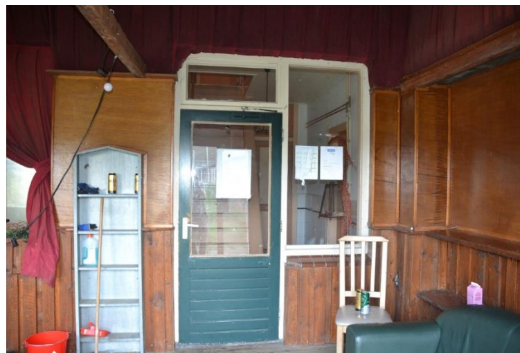
Achterdeur in de achtergevel tussen boerderij en overkapping.
