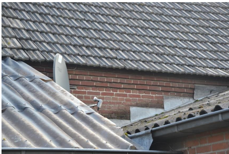
Deel van de oorspronkelijke achtergevel tussen stal en overkapping.
