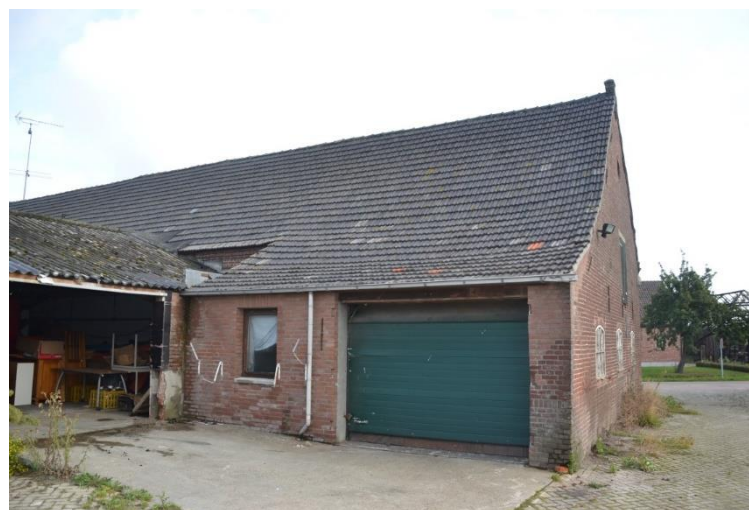
Rechterdeel van de achtergevel met garage in de zijbeuk.
