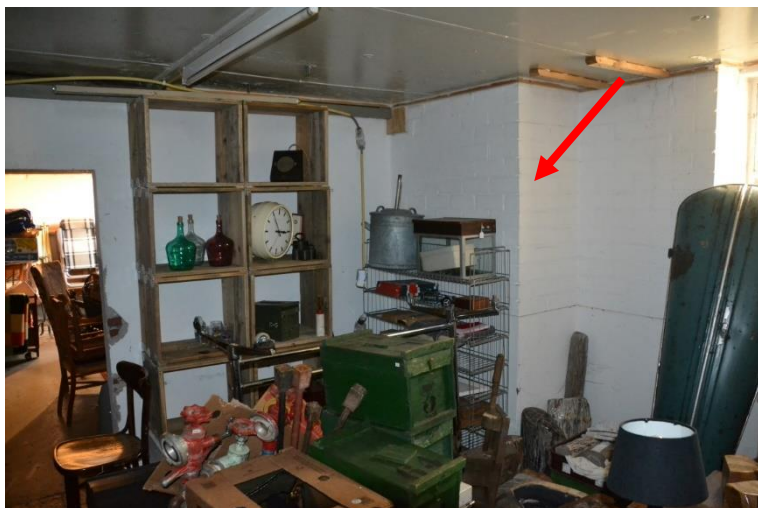
Interieur van bedrijfsgedeelte naar het noordwesten gezien met scheidingsmuur en kalkzandstenen binnenwand met meterkast achter de houten loopdeur (rode pijl).
