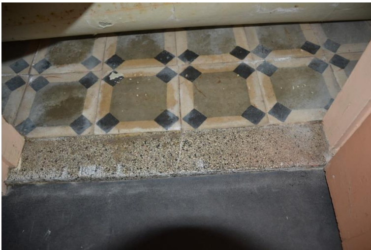
Detail inbouwkast met granito dorpel en tegelvloer.
