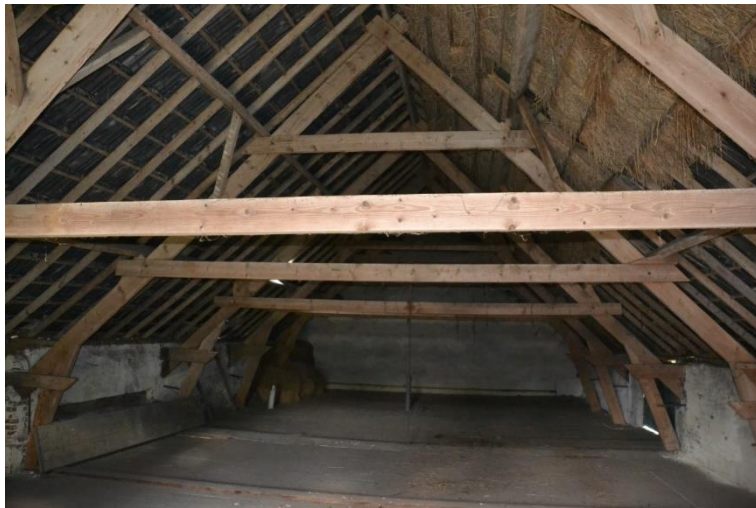
Kapconstructie boven het bedrijfsgeboude naar het westen gezien.
