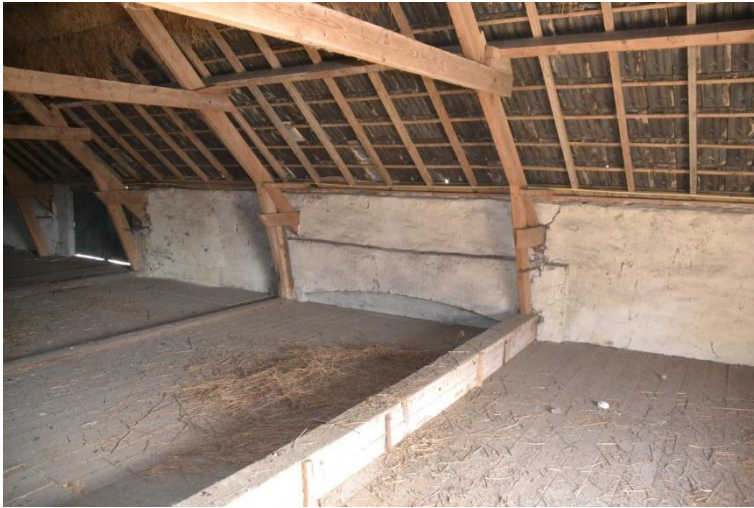
Kapverdieping naar het noorden gezien met dekbalk en vm. deeldeuropening.
