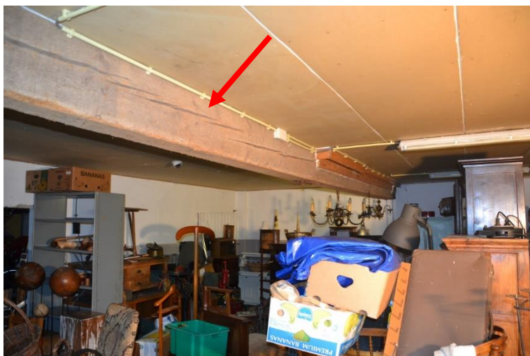
Eén van de houten moerbalken die op de gevels afdragen.
