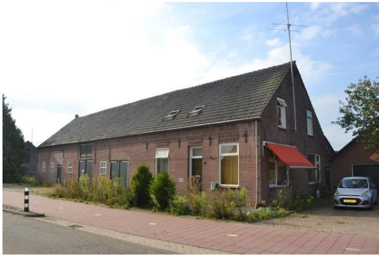
Voorgevel naar het zuidoosten gezien.
