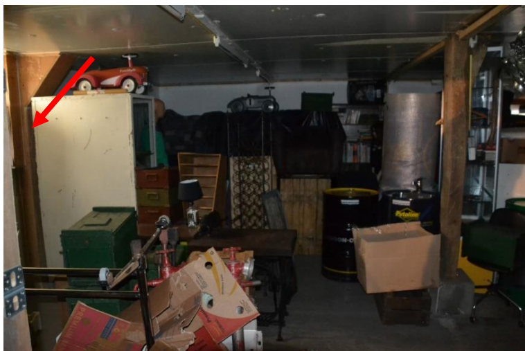
Interieur van het bedrijfsgedeelte met links de omtimmerde gebintstijl.
