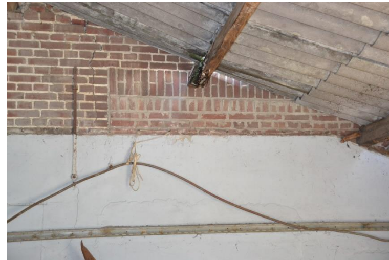
Een nog zichtbaar gedeelte van de dichtgemetselde deeldeuropening.
