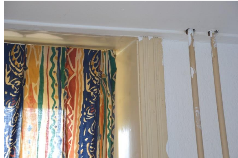
Detail authentiek binnenkozijn van vensters in de voorgevel.
