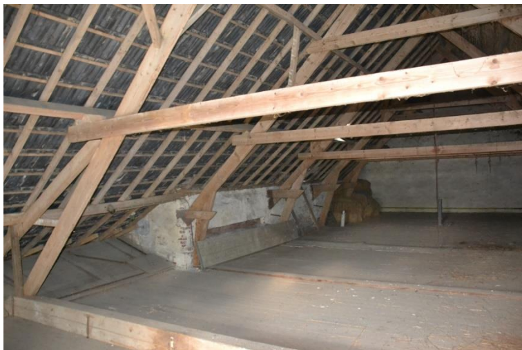
Op de voorgrond de hoger gelegen dekbalk, daarachter de lagere moerbalken. Links de dichtgezette opening in de achtergevel.
