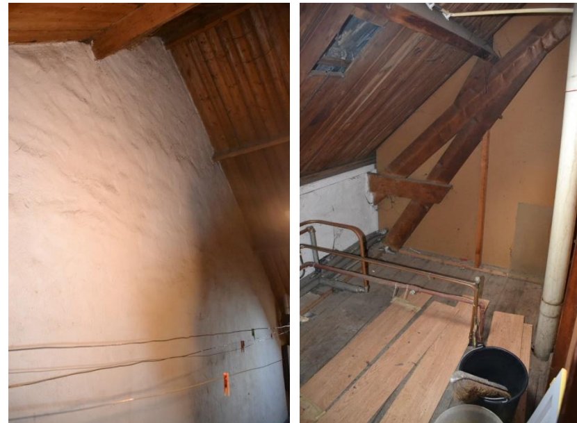
Links: brandmuur vanaf woonhuis gezien. Rechts: detail spantbenen.
