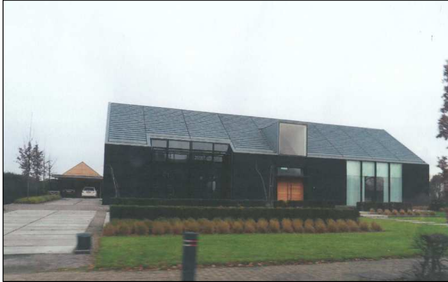
Figuur 14: Nieuwbouwwoning aan Baarschotsestraat 37
