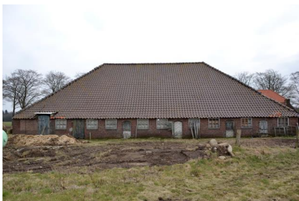
Afb. 47. Achtergevel van de kapschuur.
