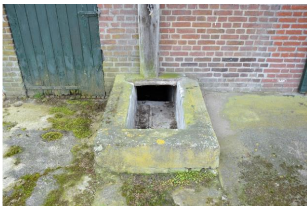
Afb. 20. Detail van rechterzijgevel met de bak waarlangs de mest uit de grupstal gezogen werd.
