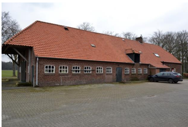
Afb. 14. Achtergevel vanuit het westen gezien.
