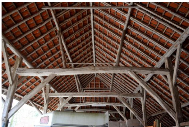
Afb. 49. Gebint- en kapconstructie kapschuur.
