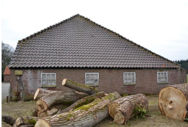
Afb. 48. Rechterzijgevel van de kapschuur.
