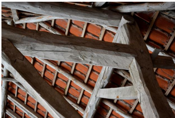
Afb. 51. Het zelfde gebint met tegenoverliggend telmerk XV.
