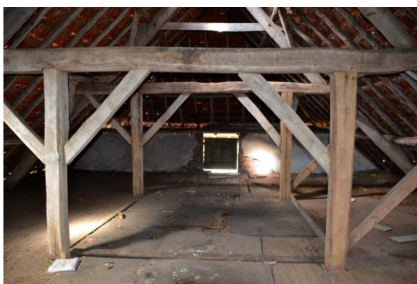
Afb. 39. De dekbalkgebinten met A-spanten in de kap.
