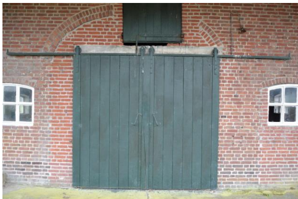
Afb. 21. Detail van rechterzijgevel. Rondom de deeldeuren is nog goed de afmeting van de oorspronkelijke deeldeuren te zien.
