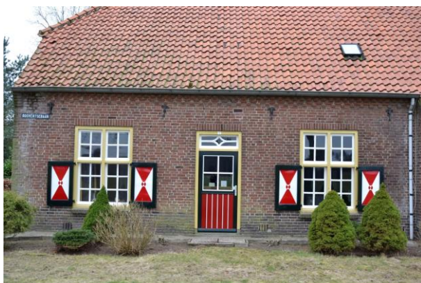
Afb. 9. Voorgevel van woonhuisgedeelte.
