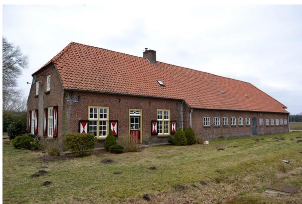
Afb. 7. Voorgevel vanaf het zuiden gezien.
