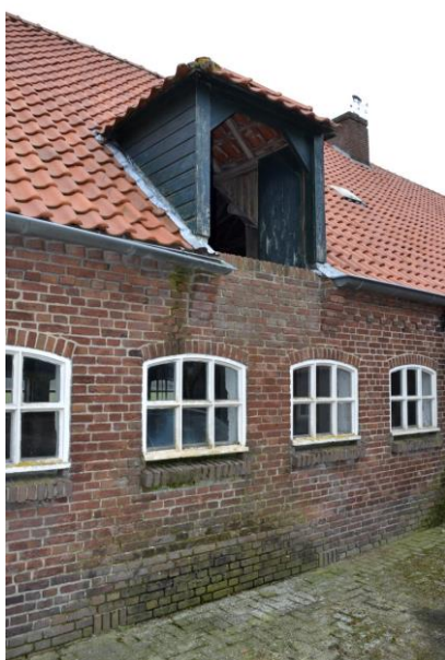
Afb. 16. Detail achtergevel bedrijfsgedeelte.
