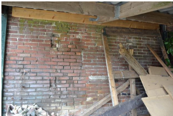
Afb. 43. Achtergevel met bouwsporen.
