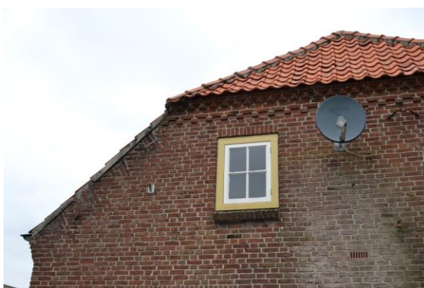
Afb. 12. Detail linkerzijgevel met vlechtingen en dubbele tandlijst.
