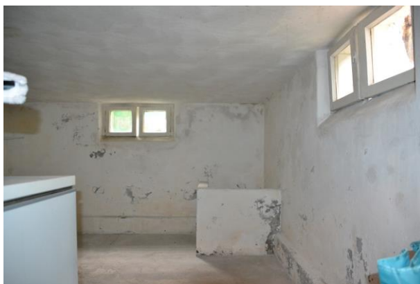
Afb. 27. De kelder naar het zuiden gezien.
