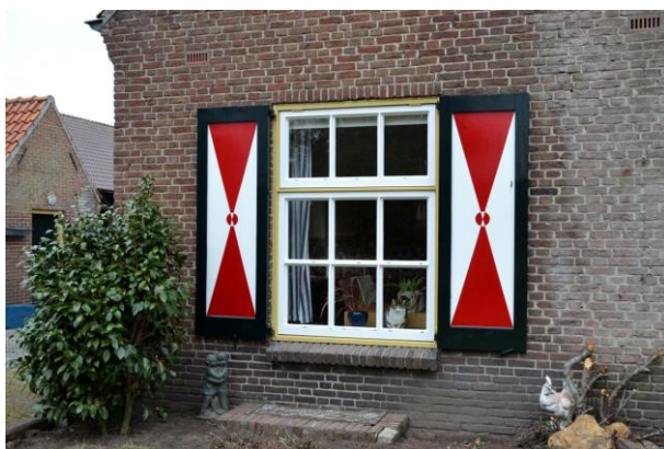
Afb. 11. Detail linkerzijgevel met venster met vernieuwde raamvullingen.
