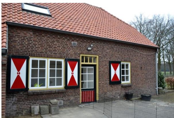
Afb. 18. De achtergevel ter hoogte van het woon-gedeelte.
