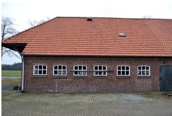
Afb. 15. Detail achtergevel bedrijfsgedeelte.
