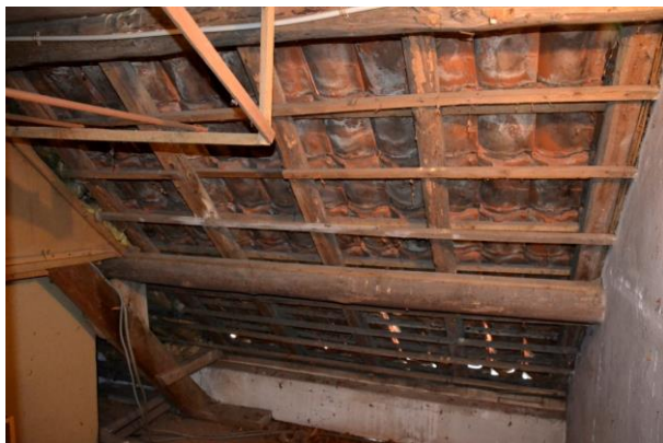
Afb. 31. Zicht op de kap boven het woongedeelte.
