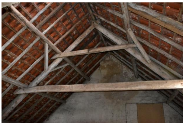
Afb. 38. Een van de A-spanten met dubbele hanenbalk.
