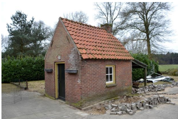
Afb. 40. Het bakhuis vanuit het noorden gezien.
