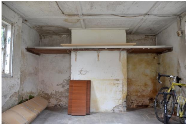
Afb. 44. Interieur bakhuis met rookkanaal.
