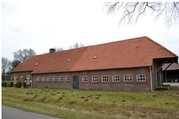
Afb. 8. Voorgevel vanaf het noorden gezien.
