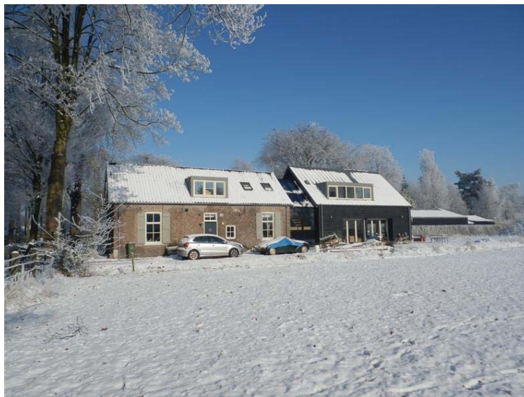
Voorbeeld van een monument met uitbreiding in hout en glas
