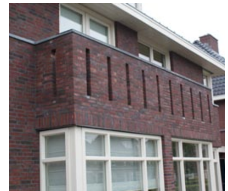
gemetselde borstwering op erker
