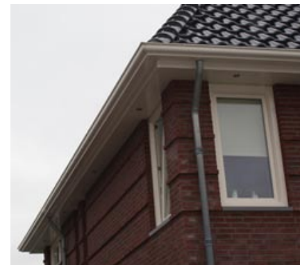
profilering in bakgoot en metselwerk
