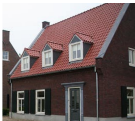
topgevel, mastgoot en gekapte dakkapel niet toegestaan
