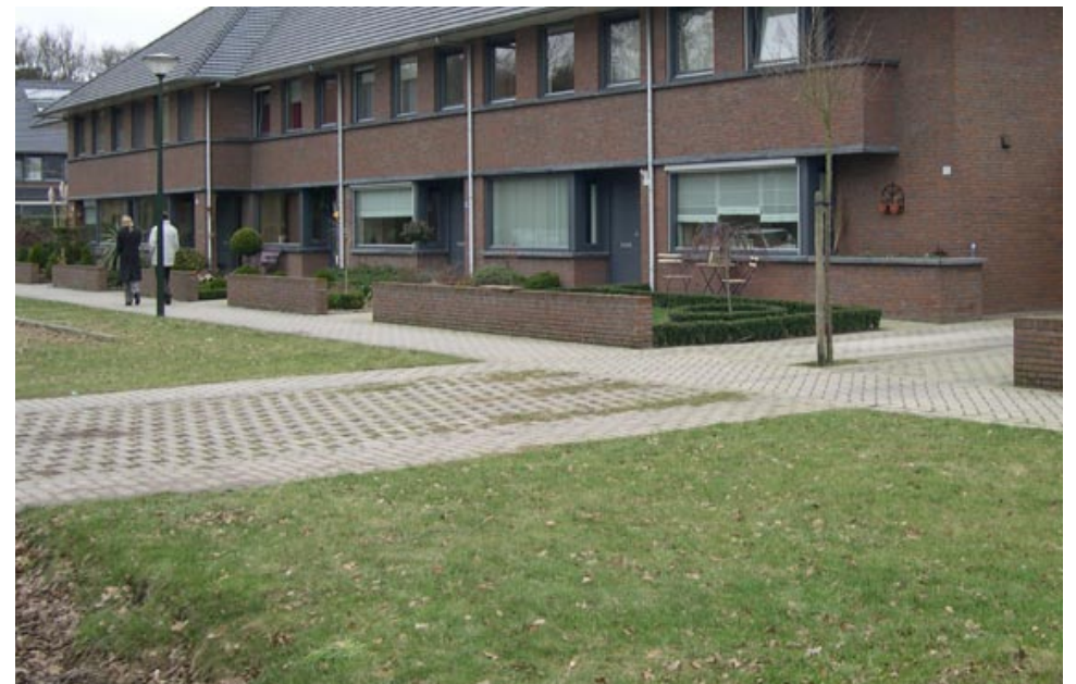
toegang tot erven over groene bestrating (grasbetontegel) - referentiebeeld gebied F
