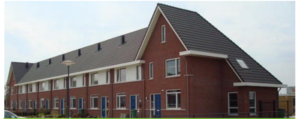
ondergeschikte houten geveldelen
