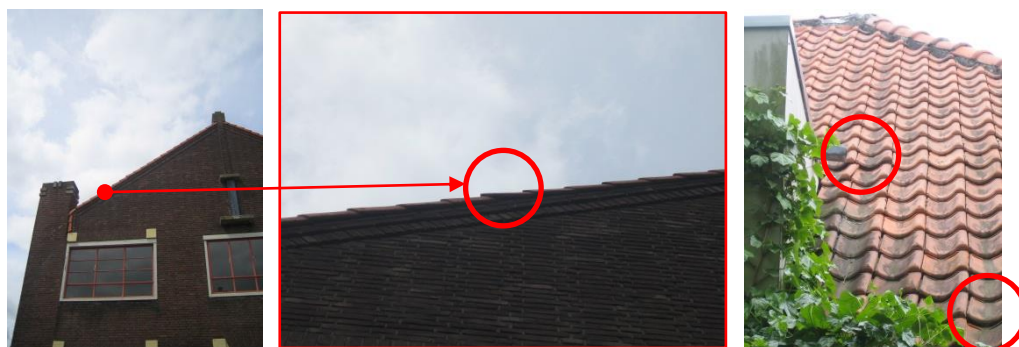
Afbeelding 4: locatie aangetroffen nest van de Huismus op het dak van het cultureel centrum (links en midden), kierende dakpannen welke in potentie toegang geven tot dakbeschot en een potentiële nestplaats kunnen vormen (rechts) (SAB, 2013).
