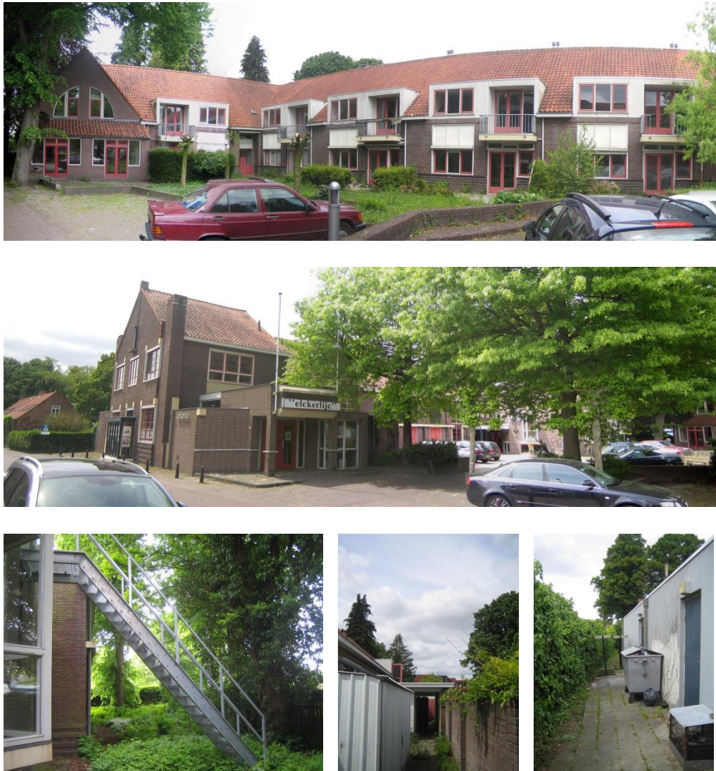
Afbeelding 2: Globale indruk plangebied. Van boven naar rechtsonder: voormalig wooncomplex van Stichting Woningbedrijf Hilvarenbeek, het cultureel centrum Elckerlijc gezien vanaf de Koestraat, achterzijde cultureel centrum, brandgang aan achterzijde wooncomplex met diverse opslagruimtes, achteringang cultureel centrum (toegankelijk vanaf de Koestraat) (SAB, 2013).
