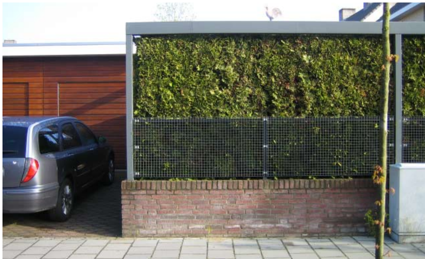
Geïntegreerde groene erfafscheiding op een bakstenen plint met raster in het binnengebied
