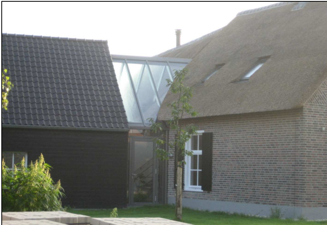
Figuur 20: Een koppellement kan ook het onderscheid tussen gebouwdelen benadrukken
