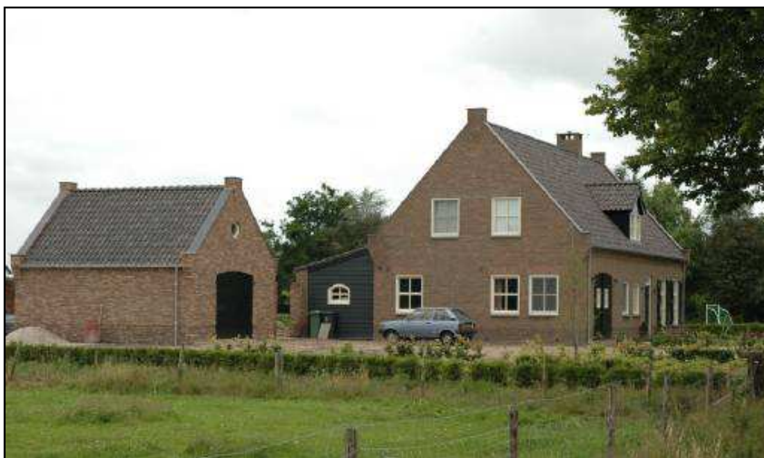
Figuur 22: Een mooi voorbeeld van een landelijk woningtype met bijpassend bijgebouw. Let ook op het subtiele gebruik van hout om de verlenging van het volume aan de achterzijde architectonisch te benadrukken
