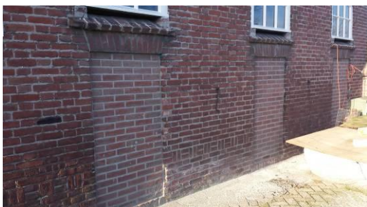
Foto links: dichtgemetselde varkensdeurtjes. Foto rechts: gewelfd dak ter plaatse van het hooiluik.
