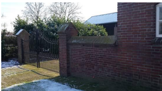
Foto links: muur met ezelsrug en penanten aan de achterzijde in het verlengde van de gevel van de straatzijde gezien.
