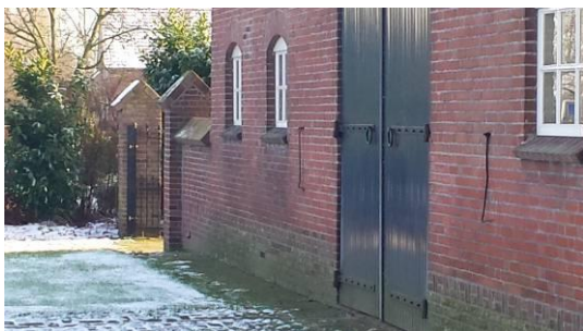
Foto links: gevel achterhuis met deeldeuren en houten stalramen.
