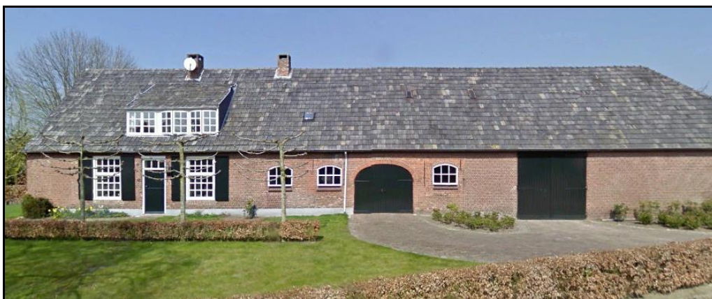
Huidige situatie plangebied (bron: Google Earth)
