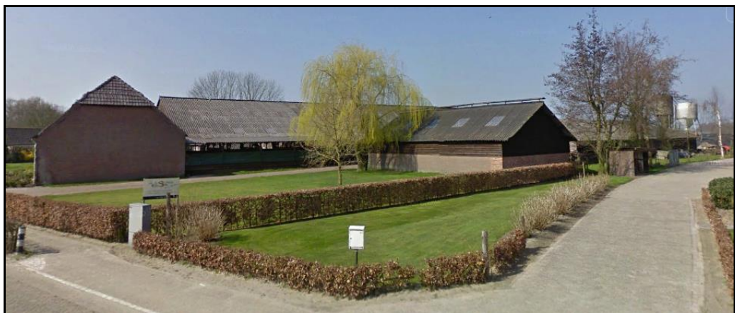
Huidige situatie plangebied (bron: Google Earth)
