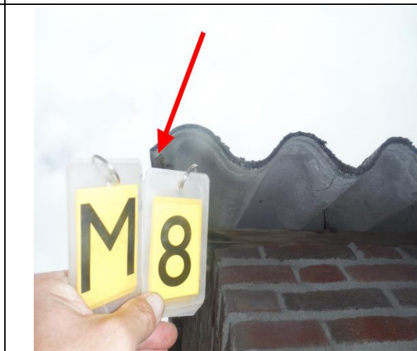
Foto 21 | Foto voor M8 Golfplaat incl. nokstukken, dakafwerking garage
