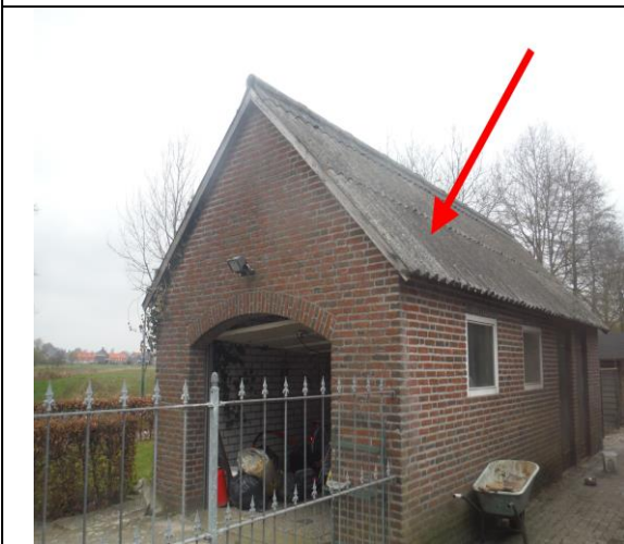
Foto 20 | Foto voor M8 Golfplaat incl. nokstukken, dakafwerking garage
