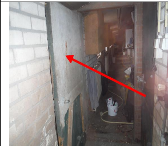
Foto 7 | Foto voor M3 Vlakke plaat, deurbeplating
