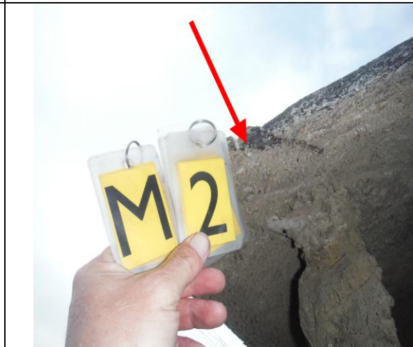
Foto 4 | Foto voor M2 Vormstuk, ventilatieschacht
