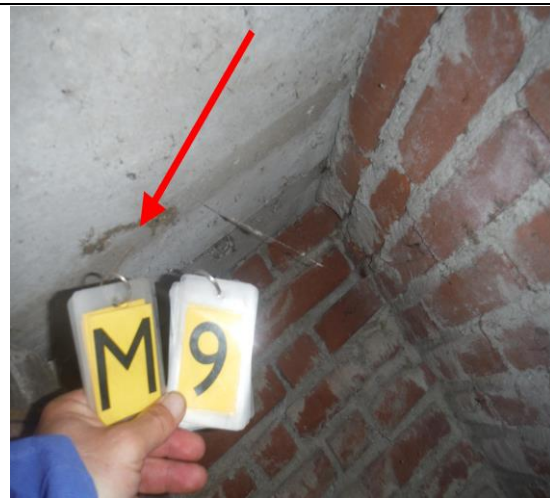
Foto 23 | Foto voor M9 Vlakke plaat, plafondbeplating
