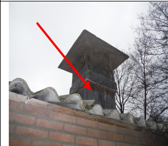
Foto 3 | Foto voor M2 Vormstuk, ventilatieschacht
