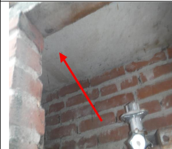
Foto 22 | Foto voor M9 Vlakke plaat, plafondbeplating
