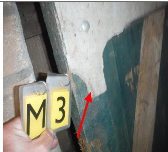
Foto 8 | Foto voor M3 Vlakke plaat, deurbeplating
