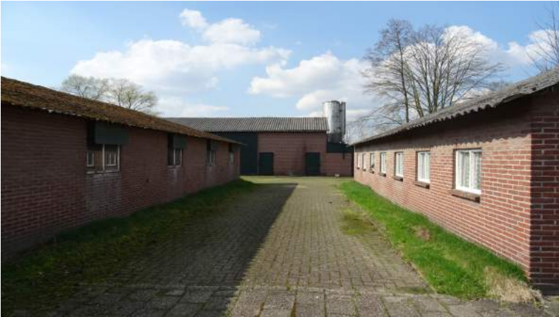
Drie te slopen schuren in het plangebied Tongerloseweg 2
