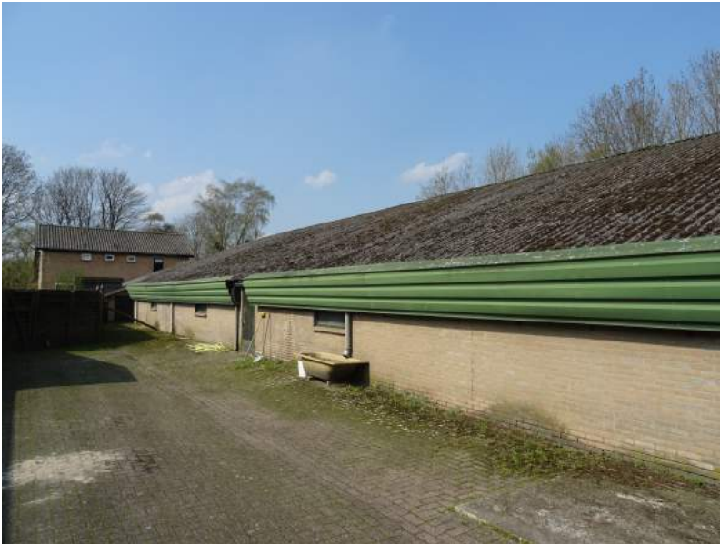
Te slopen varkensstal binnen het plangebied
