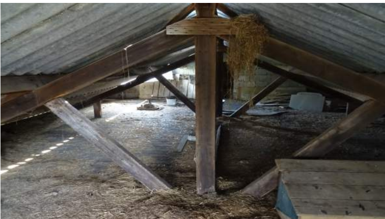
Zolder boven één van de schuren bij de Tongerloseweg 2
