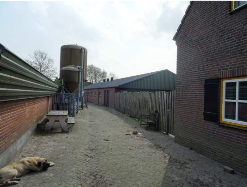
Links en achter twee schuren van het plangebied Hakvoortseweg 34, rechts het naastgelegen woonhuis
