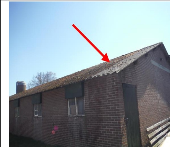
Foto 1 | Foto voor M1 Golfplaat incl. nokstukken, dakafwerking schuur I
