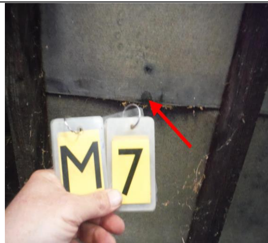
Foto 18 | Foto voor M7 Vlakke plaat, plafondbeplating
