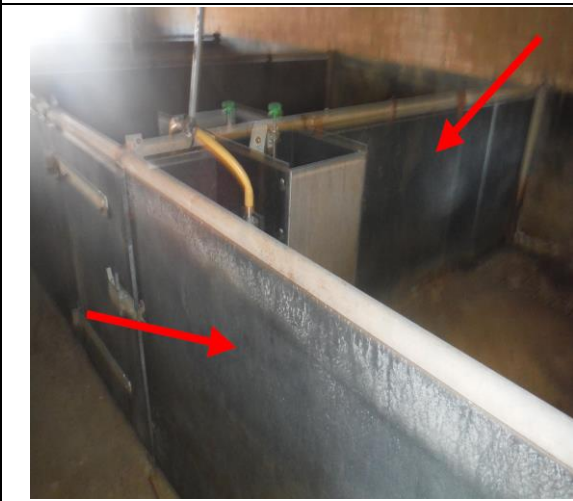
Foto 9 | Foto voor VM1 Vlakke plaat, stalschot
