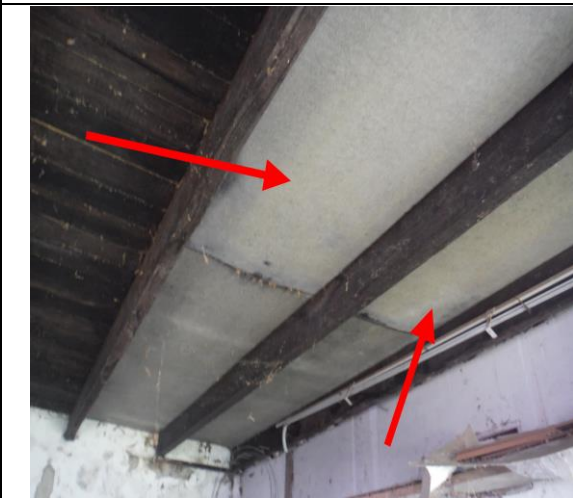
Foto 17 | Foto voor M7 Vlakke plaat, plafondbeplating
