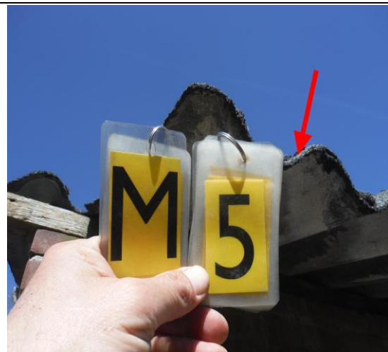
Foto 11 | Foto voor M5 Golfplaat, dakbeplating schuur 2
