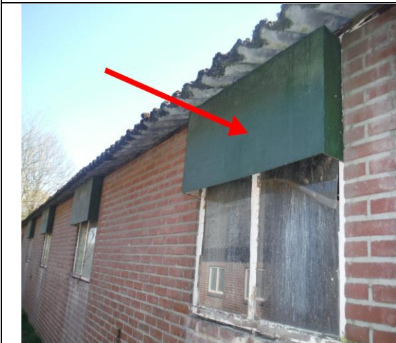
Foto 3 | Foto voor M2 Vlakke plaat, gevelbekleding
