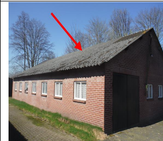
Foto 10 | Foto voor M5 Golfplaat, dakbeplating schuur 2
