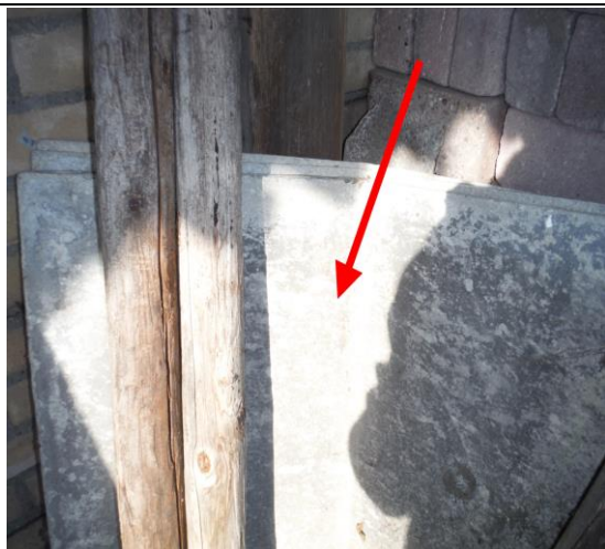
Foto 7 | Foto voor bron Vormstuk, nokstukken A
