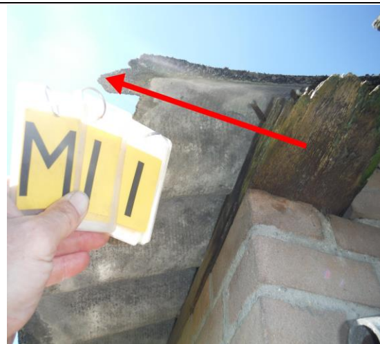
Foto 23 | Foto voor M11 | Golfplaat incl. nokstukken, dakafwerking schuur 2
