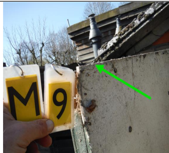
Foto 18 | Foto voor M9 Board, deurbeplating
