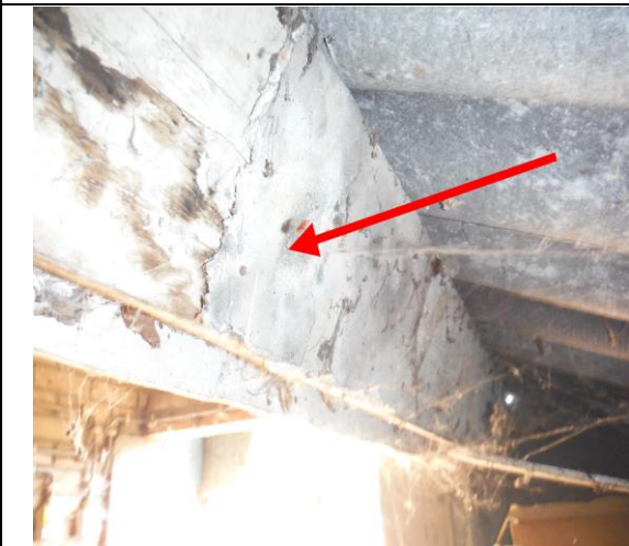
Foto 15 | Foto voor M8 Vlakke plaat, wandbeplating
