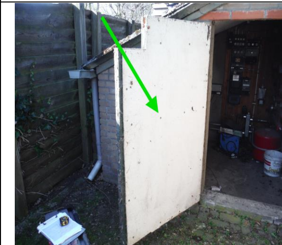
Foto 17 | Foto voor M9 Board, deurbeplating
