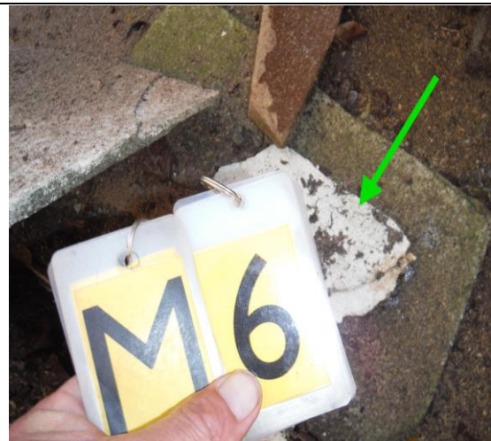
Foto 12 | Foto voor M6 Vlakke plaat, restanten
