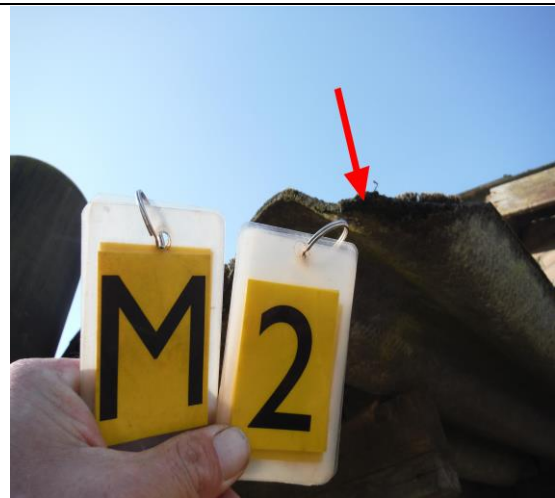
Foto 4 | Foto voor M2 Golfplaat, dakbeplating
