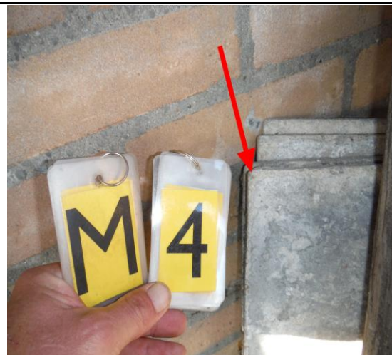
Foto 8 | Foto voor bron Vormstuk, nokstukken A
