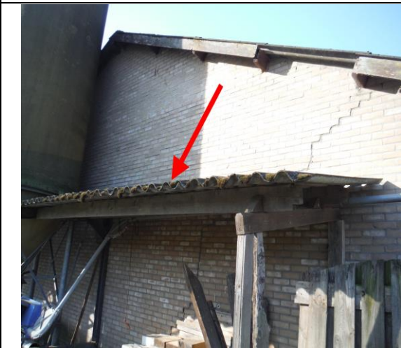
Foto 3 | Foto voor M2 Golfplaat, dakbeplating
