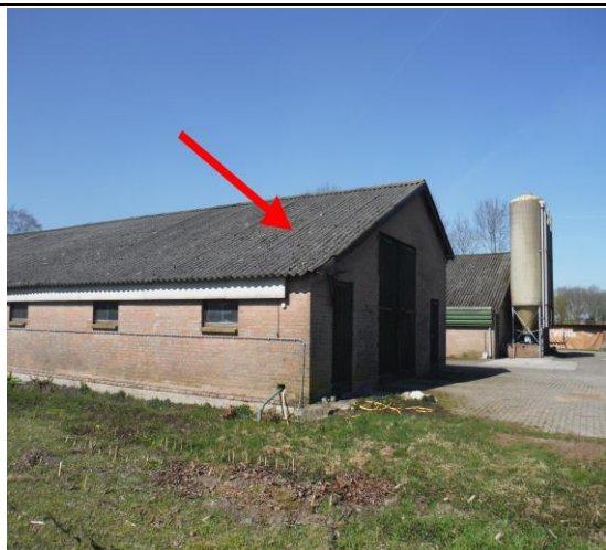
Foto 22 | Foto voor M11 | Golfplaat incl. nokstukken, dakafwerking schuur 2
