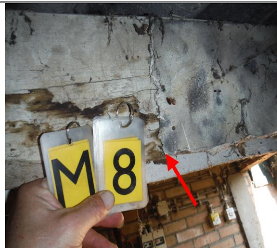
Foto 16 | Foto voor M8 Vlakke plaat, wandbeplating
