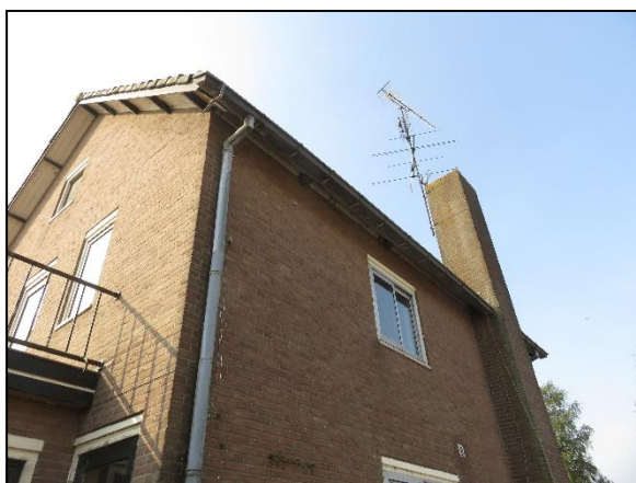
Foto 3. Noordzijde van te verbouwen woning
