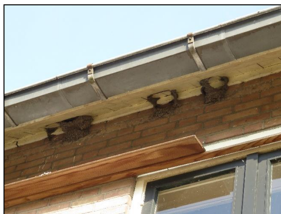
Foto 4. Huiszwaluwnesten tegen dakrand woning
