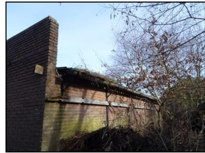
Figuur 4. Meest zuidelijke schuur.
