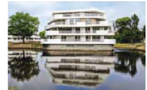
Etalage aan de A59
