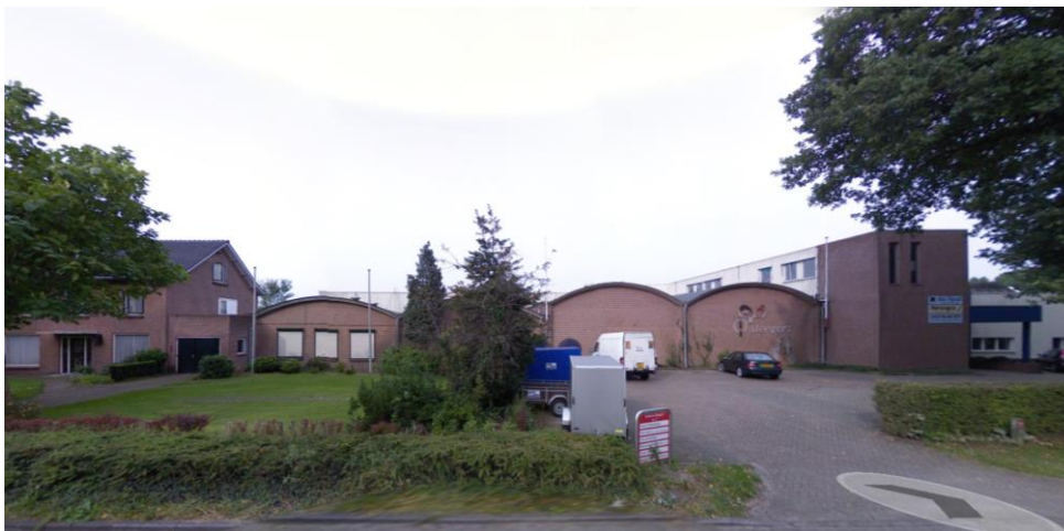
Huidige situatie van vóór de brand (bron: Google Streetview)
