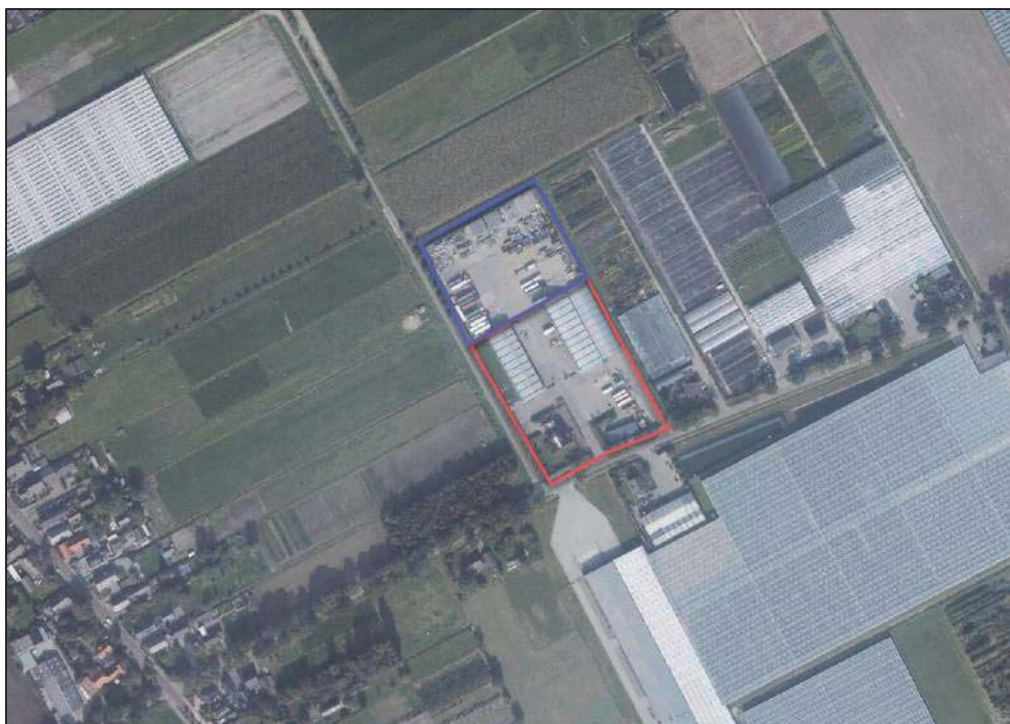
Figuur 1 Overzicht projectlocatie met omliggende bebouwing
