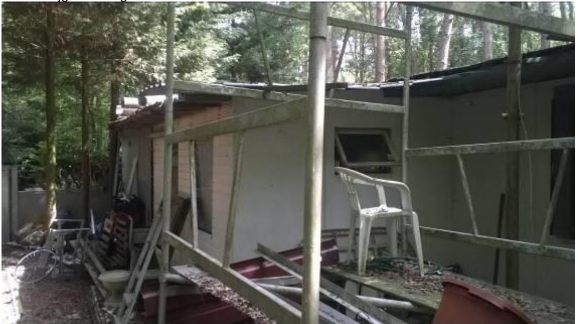
Achtergevel vanaf linkerszijde gedeelte steigertoren
