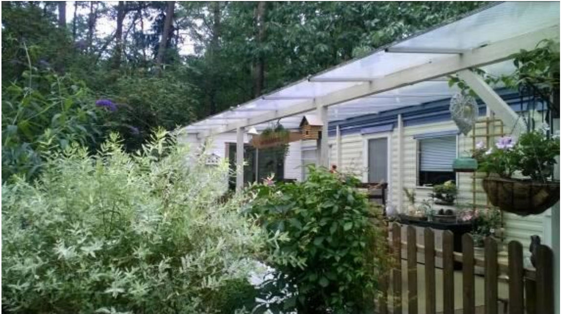
Voorgevel met overkapping
