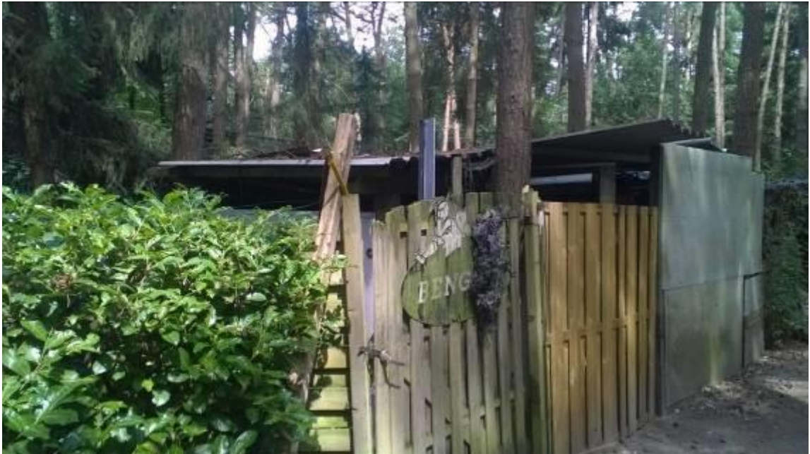
Linker aanzicht van voorgevel bergingen en overkapping
