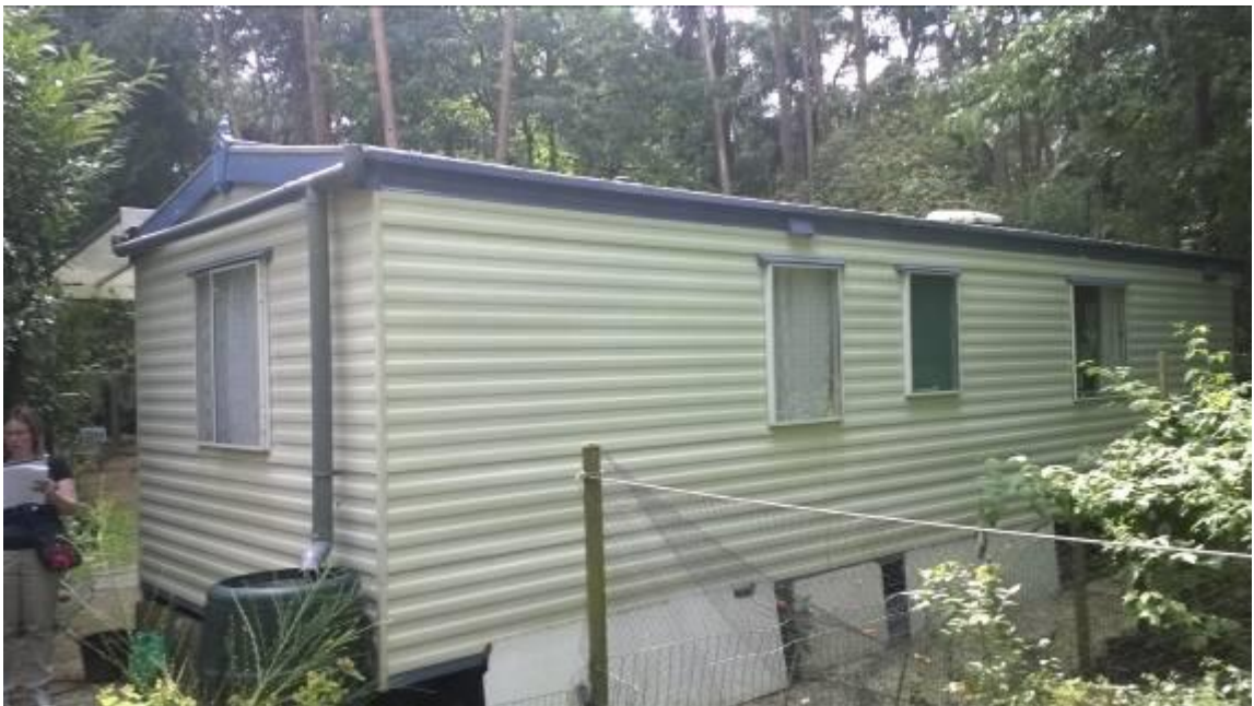
Achtergevel vanaf rechterzijde
