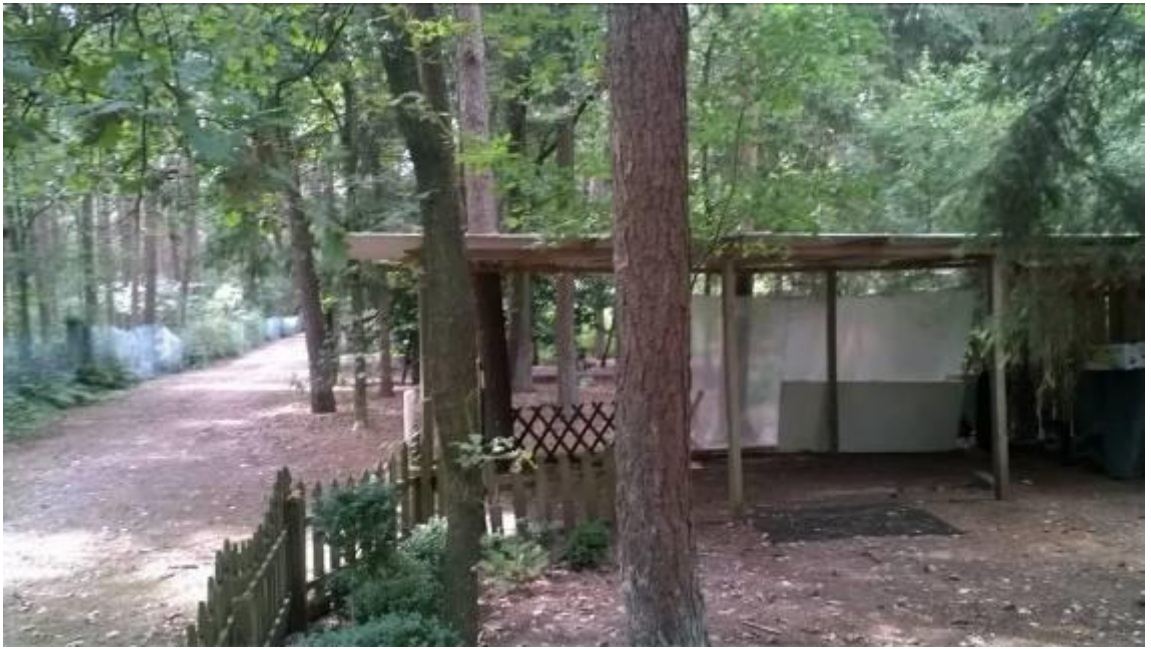
Carport aande voorzijde van het terrein
