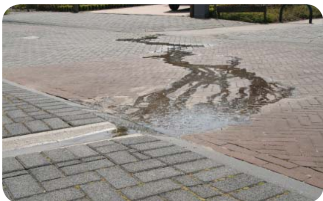
Water van de woning naar de straat
