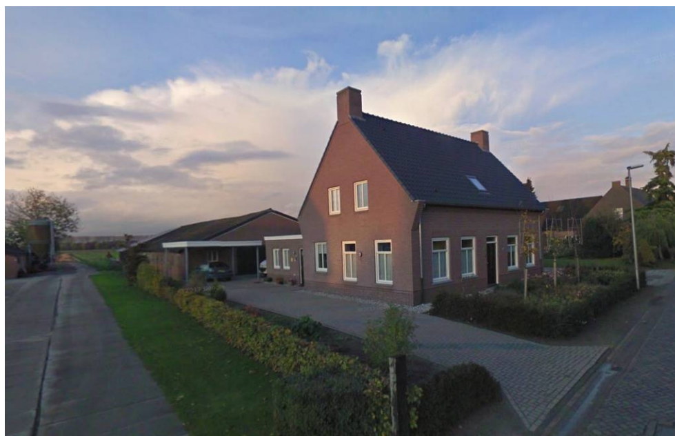
Afbeelding 7 - Foto overzicht bestaande bedrijfswoning.
