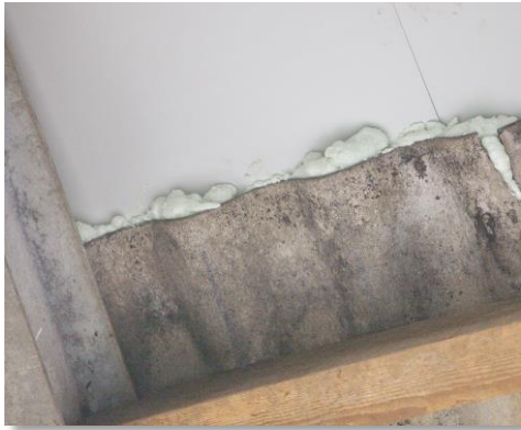
Figuur 7c: binnenzijde dichtgepurde nok
