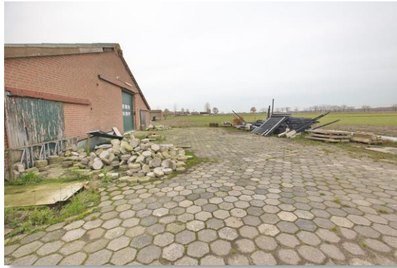
Figuur 8b: achterzijde schuur
