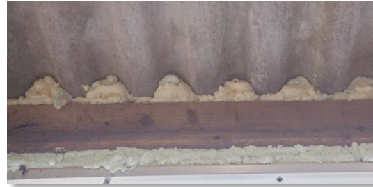
Figuur 7c: binnenzijde dichtgepurde schuur
