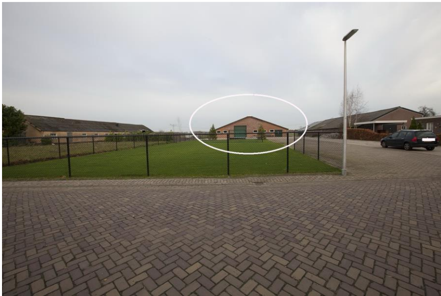
Figuur 7a: front schuur A (links) met ruimtes tussen dakpannen en in pandige softboard betimmering (kijkrichting positie a, figuur 9). Rechter schuur niet aanwezig in afbeelding 6b.
