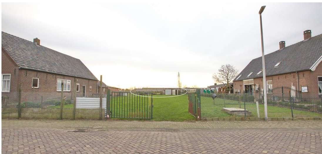
Figuur 7: Graslandje inclusief moestuintje (links) met schapenstal met aan beide zijden een losstaand woonhuis
