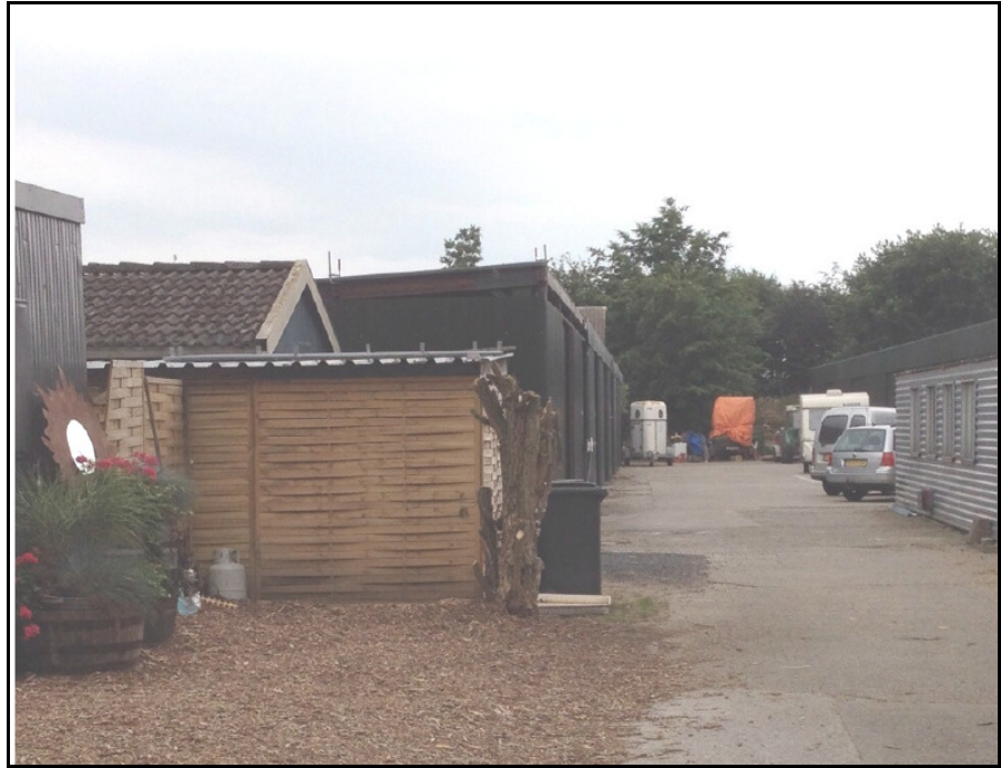
Figuur 4 Beeld van bestaande situatie op het perceel
