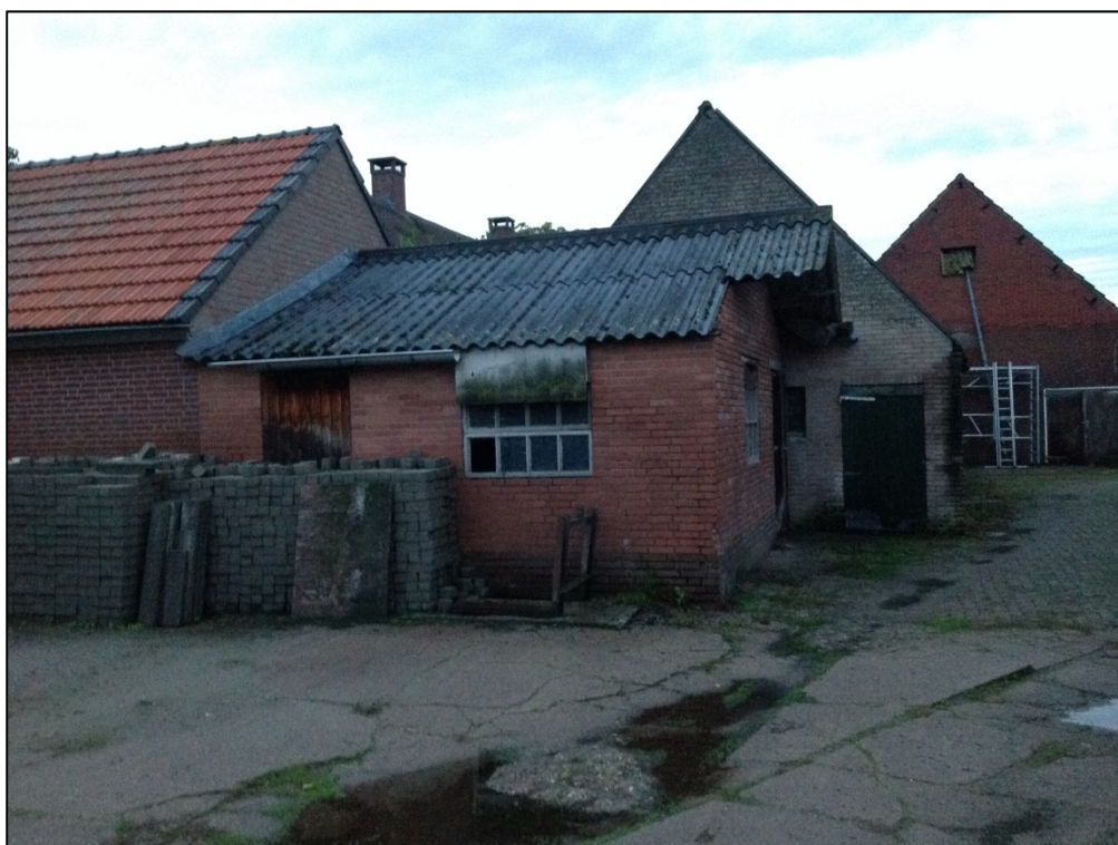
Foto 7 zicht naar schuren aan voorzijde op perceel en achterzijde hoofdgebouw (rechts)
