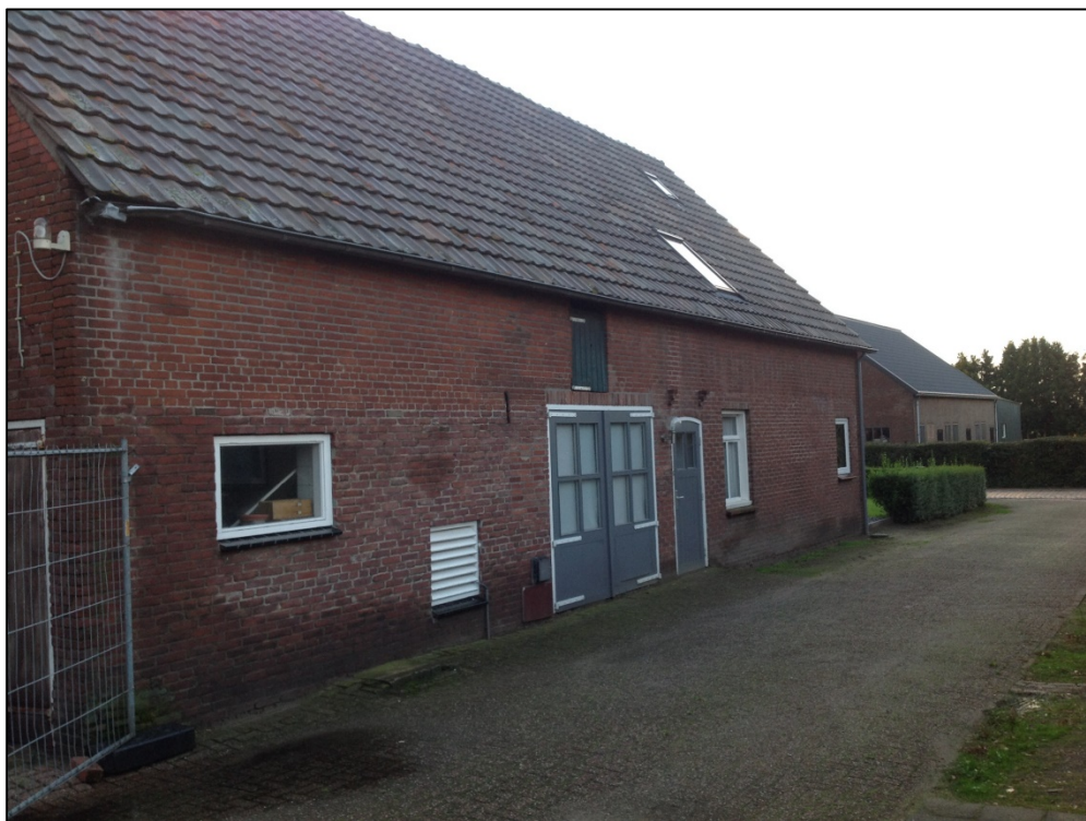
Foto 2 Achterste deel hoofdgebouw
