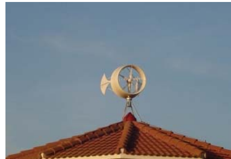
Figuur 3.3: gebouwgebonden windturbine
