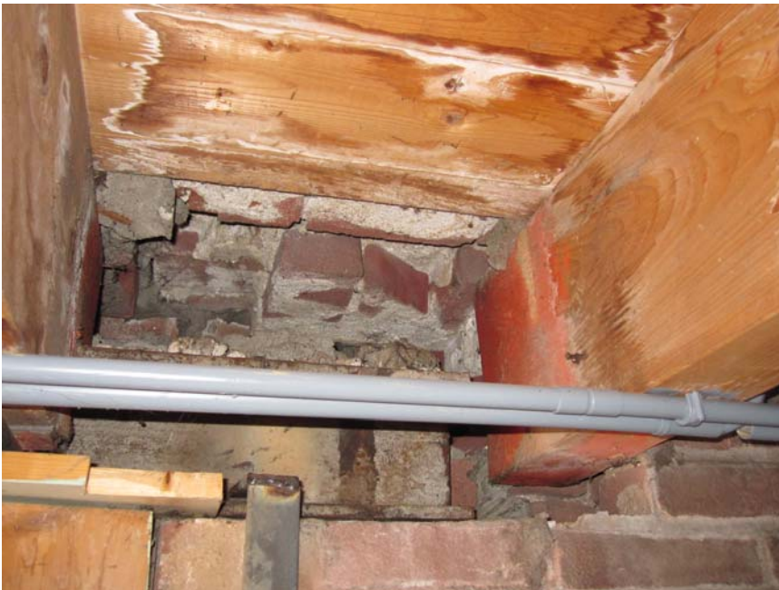
afb. 26: Aansluiting van de binnenzijde van de achtergevel van de oude opslaghal tegen de vloer van de derde bouwlaag. Rechtsonder en achter de vloerdelen tussen de balken is nog net het gevelmetselwerk van het gesloopte silogebouw (1925) zichtbaar. Achter de balken is de koppenlaag van de steens dikke binnenspouwmuur zichtbaar.
