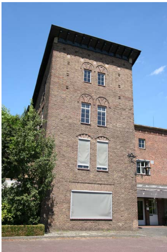
afb. 11: Voorgevel kantoorpaviljoen waarin de diverse gevelopeningen met eigen beëindigingen rond één vensteras.
