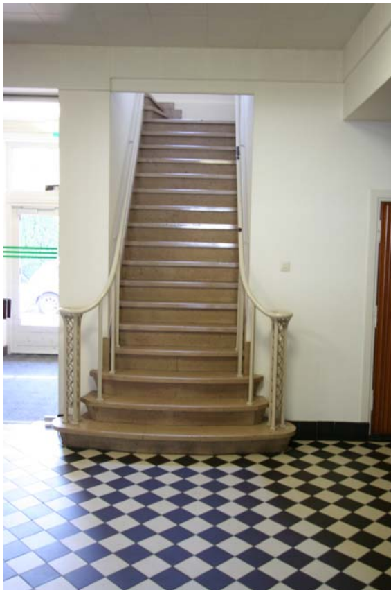
afb. 28: de met natuursteen beklede trap naar de tweede bouwlaag van het oude kantoor (rechts). Aan de bovenzijde van de trap (links) zijn nog net de twee treden zichtbaar die aansluiten op de vloer van de tweede bouwlaag van de nieuwe kantoorvleugel.
