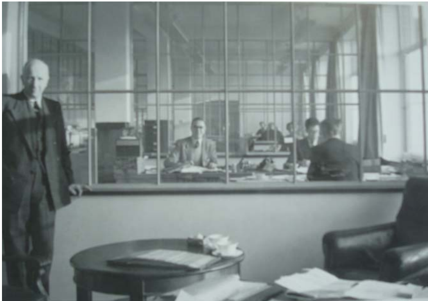
afb. 17: Foto uit de jaren '50 van het kantoor op de eerste bouwlaag van bouwdeel d met de stalen puien op de gepleisterde (lage) borstwering.
