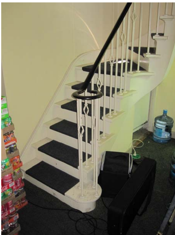
afb. 32: De houten trap in het portaal op de eerste bouwlaag van de nieuwe kantoorleugel (bouwdeel e) met gesmede balustrade.
