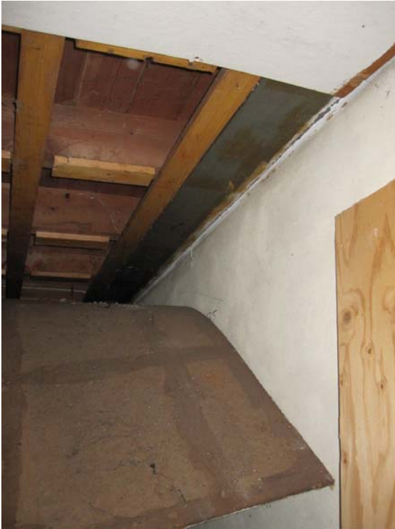
afb. 23: Stalen onderslag waarop het buitenspouwblad van de achtergevel van het bouwdeel met het lessenaarsdak van het oude kantoor is geplaatst en het platte dak van bouwdeel b aansluit.
