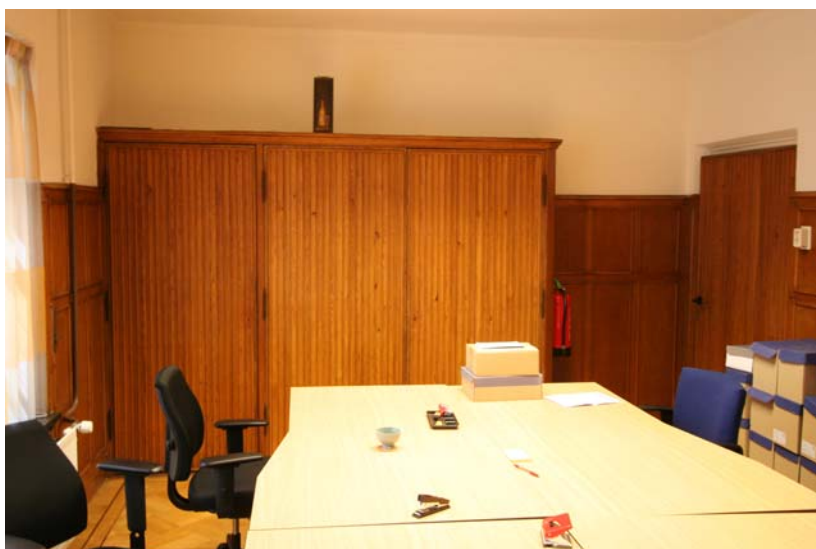
afb. 12: Voormalige directiekamer met de lambrisering en het eikenhouten mozaïekparket. Tegen de wand staat de driedelige vaste kast opgesteld met deuren die voorzien zijn van smalle delen.
