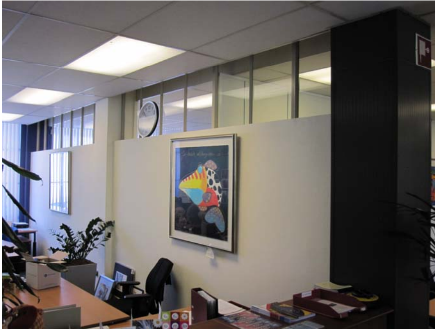
afb. 29: Betonnen kolommen van de eerste bouwlaag van de nieuwe kantoorvleugel met daartussen de stalen puien, die waarschijnlijk gedeeltelijk zijn afgeplaat. Aan weerszijden van de stalen pui zijn de systeemwanden en- plafonds zichtbaar.
