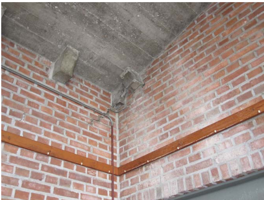
afb. 35: De onderzijde van het lessenaarsdak van bouwdeel e. De in het werk gestorte betonplaat wordt ondersteund door prefab betonnen consoles. Geheel rechts onder is de stalen onderslag zichtbaar waarop de achtergevel van dit bouwdeel is geplaatst.
