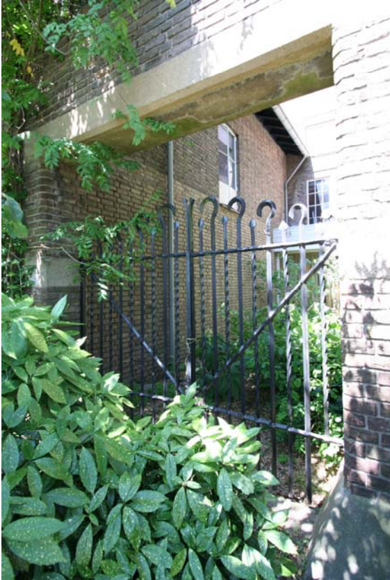
afb. 9: Smeedijzeren hekwerk in de rechthoekige doorgang tussen het woonhuis (links) en het kantoor. De bovenrand van het dak bevond zich op de scheiding van de lichte en meer grauwe baksteen op de zijgevel van het woonhuis.
