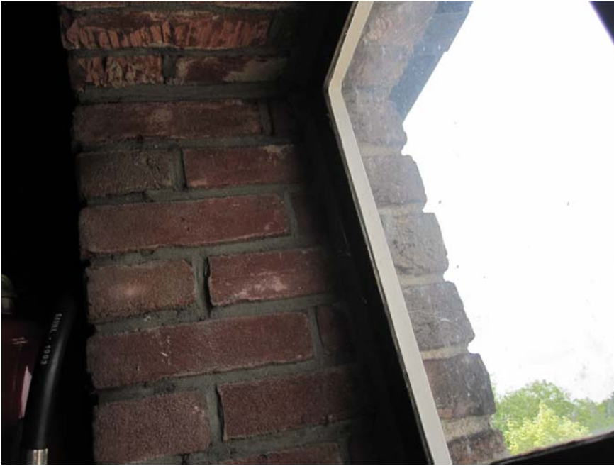
afb. 15: Dagkant van een gevelopening met aan de binnenzijde een afwijkende lagenmaat en steentype t.o.v. de buitenzijde (door het glas zichtbaar).
