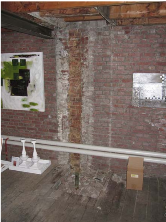
afb. 24: Weggehakt kanaal t.b.v. ventilatie of schoorsteen tegen de westelijke buitenmuur op de derde bouwlaag van de oude opslaghal (bouwdeel c).
