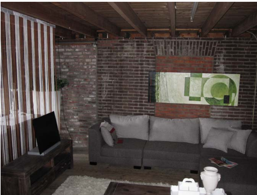
afb. 16: Rechter gedeelte van de gevel van het silogebouw uit 1926 op de derde bouwlaag. Links is de dichtgezette (deur)opening zichtbaar en achter het schilderij een raamopening die beëindigd wordt met een strekse boog.
