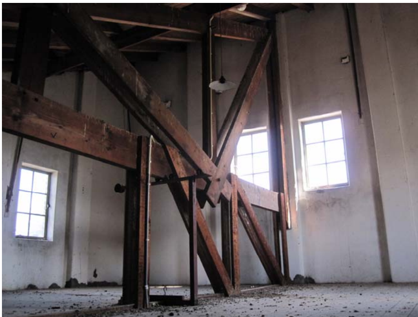
afb. 14: Houten spantconstructie onder het lessenaarsdak van het oude kantoordeel (bouwdeel b) met de ruwhouten koppelregels tussen vloer en spant. Vlak boven de vloer zijn de herstellingen in het pleisterwerk zichtbaar die verband houden met het inbrengen van de nieuwe vierde bouwlaag.
