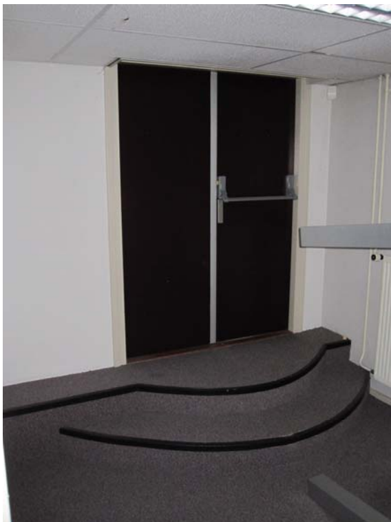
afb. 31: Twee treden voor de tussendeur in de nieuwe kantoorleugel van bouwdeel d naar e.
