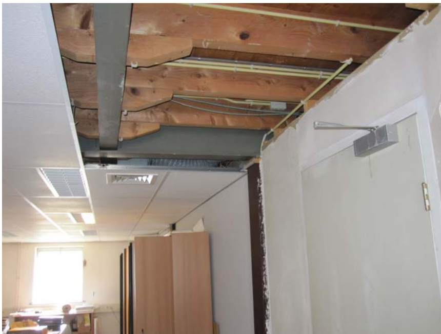
afb. 30. Geheel afgewerkte tweede bouwlaag van de nieuwe kantoorvleugel. Het ontbrekende gedeelte van het systeemplafond laat de stalen vloerconstructie van de derde bouwlaag zien met een houten balklaag op klossen.
