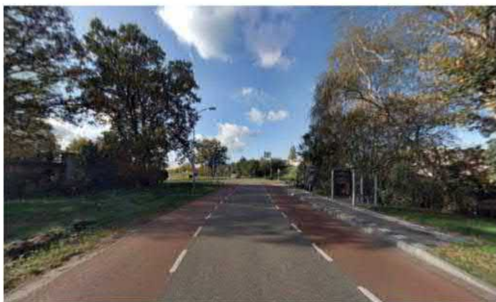
Figuur: 4.4: Huidige situatie Bosschebaan (bron: Cyclomedia).
