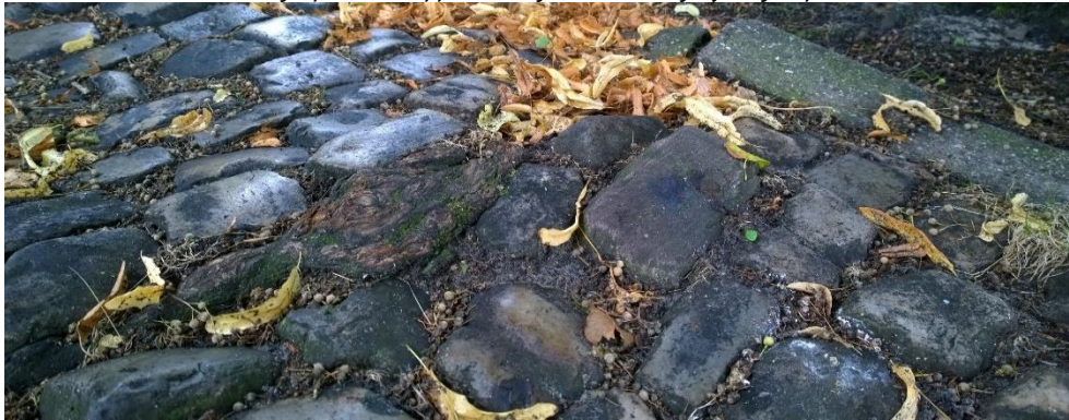
Foto 14. Verhardingsopdruk en oppervlakkige beworteling bij de groep linden (boom 9 t/m 18)
