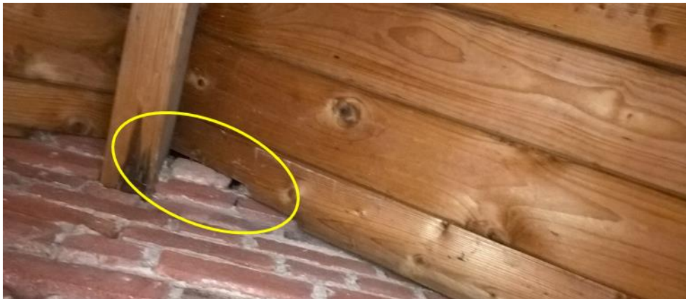
Foto 6. Potentiële verblijfplaats (binnen gele cirkel) onder houten overkapping bij sacristie
