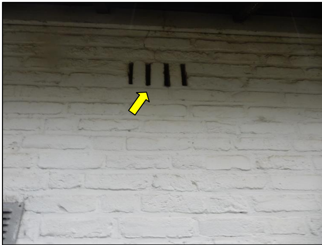
Figuur 12. Ontluchtingsgaten die toegang verlenen tot de spouw.
