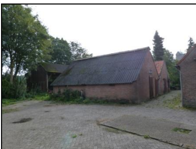
Figuur 15. Verharding en schuren op zuidelijk deel van de onderzoekslocatie.
