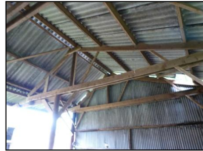
Figuur 11. Dak van de open kapschuur.
