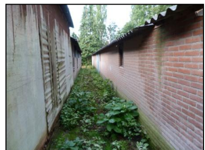
Figuur 8. Pad tussen de opstallen op het noordelijke terreindeel.
