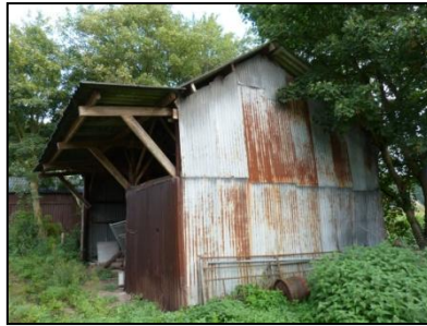
Figuur 10. Open kapschuur op zuidelijk deel van de onderzoekslocatie.
