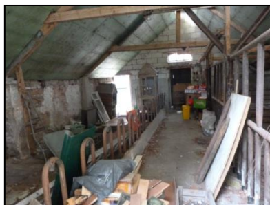
Figuur 16. Binnenzijde één van de schuren.
