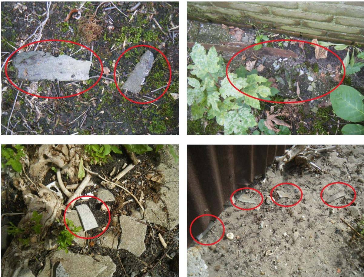
Figuur 2. Foto's asbestverdacht (plaat)materiaal tijdens terreininspectie
