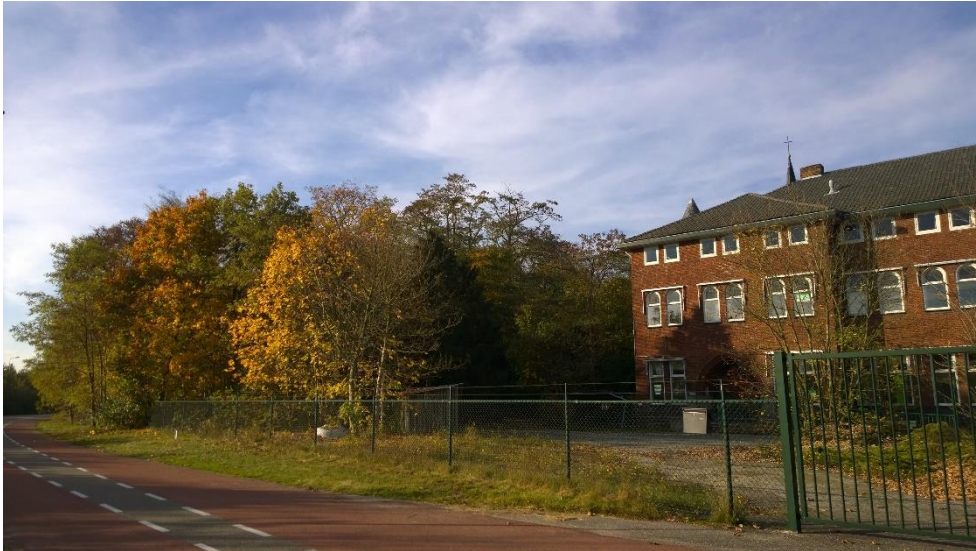
Foto 2. Situatie beukenlaan westzijde terrein
