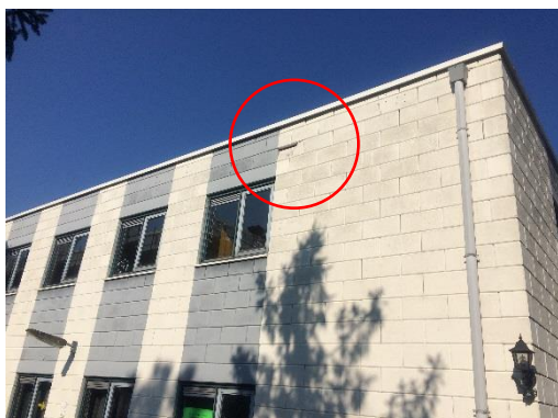
Foto 9 oostgevel met opening
